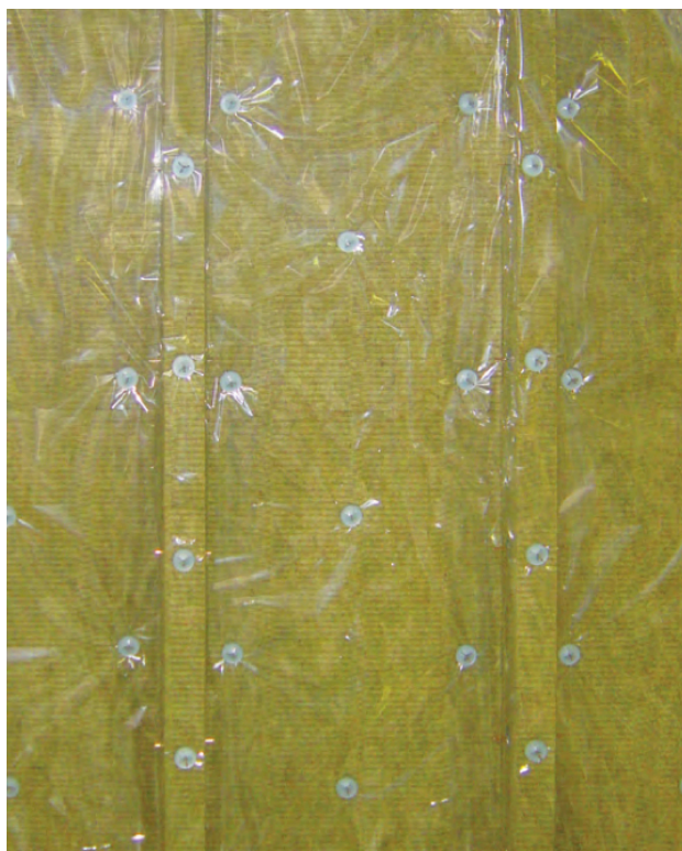
Imagen 23. Laminado acústico instalado.
