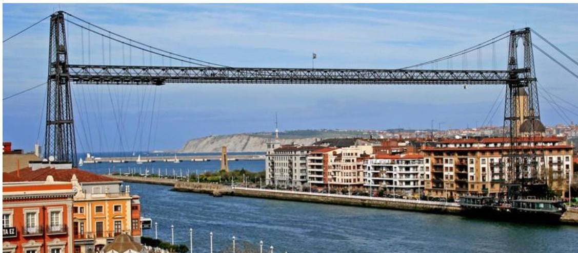
Figura 1: El puente transbordador de Portugalete a Las Arenas.
