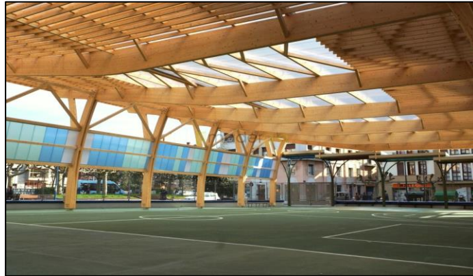
Figura 6 .Cubierta de patio de CEIP en madera
