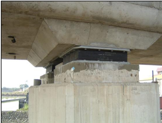
Figura 23. Ejemplo de apoyo elastomérico.
