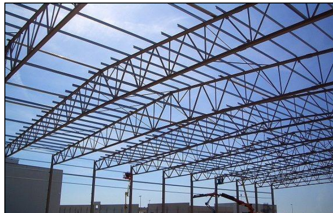
Figura 12. Construcción en celosía [14].
