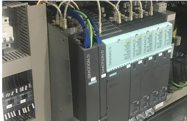
FIGURA 5. EJEMPLO DE INSTALACIÓN SIMOTION D
