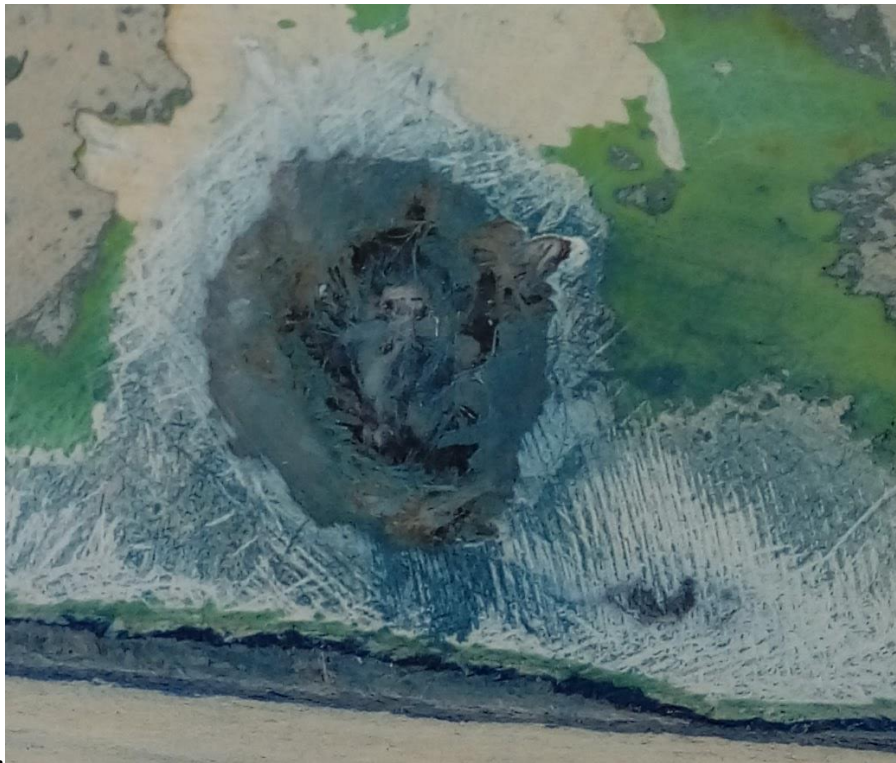
Ilustración 12: Zona afectada por ósmosis.
