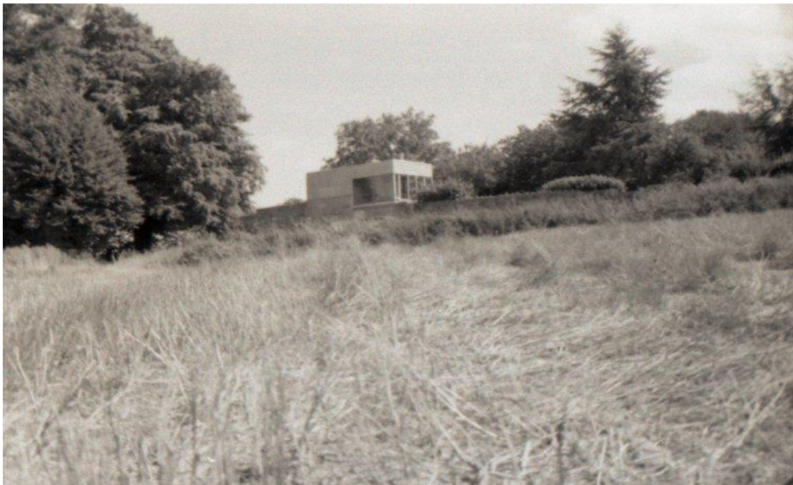
Figura 3. Fotografía de la fachada norte de Upper Lawn con la caja de aluminio introducida entre la vegetación y el muro de mampostería, agosto de 2016. (Fuente: Alberto Díez Gómez)
