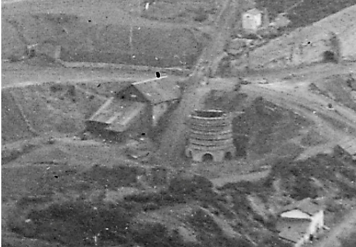
Figura 10. Fotografía en la que aparecen el horno nº1 y el lavadero de la mina Amalia Vizcaína. 1910-1920. (Fuente: Fondo Mac Lennan del Archivo Municipal de Fotografías Antiguas Muskiz).
