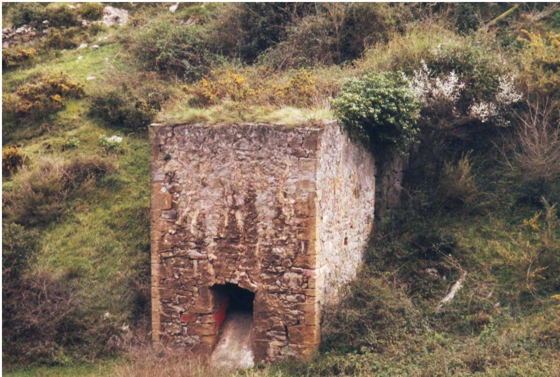
Figura 7. Horno de calcinación de la mina Demasía a Complemento de Covarón, Muskiz. 2013. (Fuente: Centro de Interpretación Peñas Negras).
