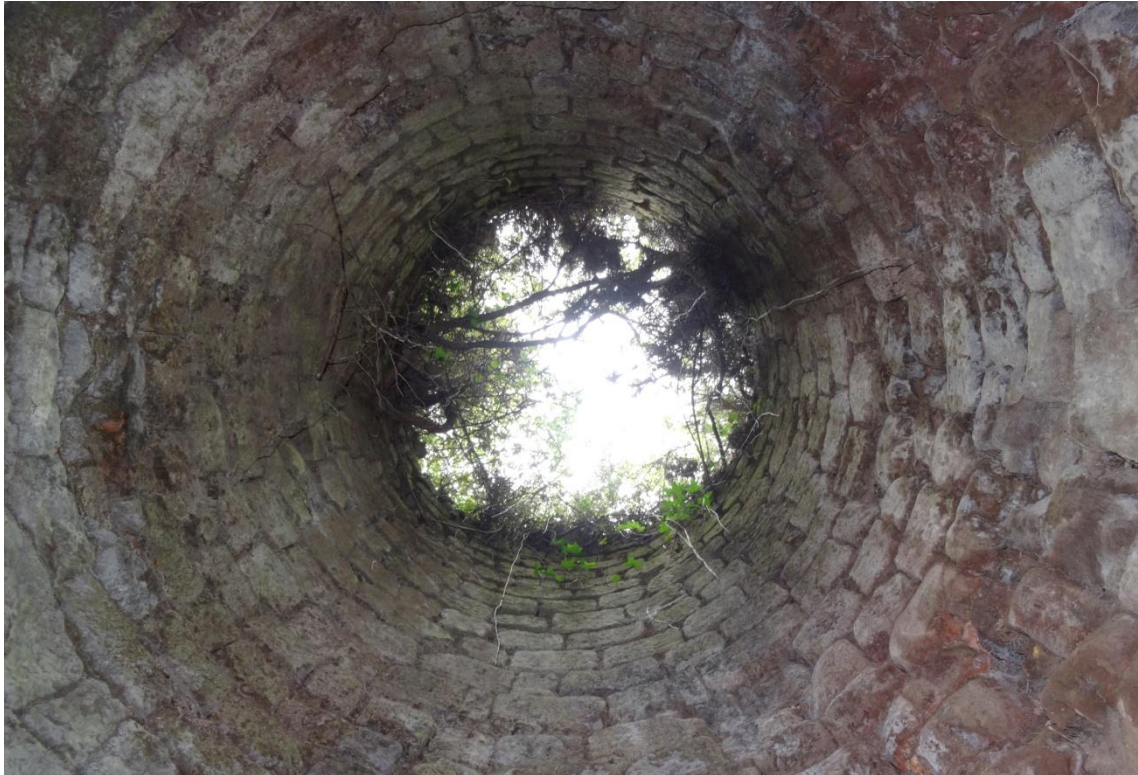
Figura 8. Interior del horno de calcinación de la mina Demasía a Complemento de Covarón, Muskiz. 2017. (Fuente: Mainer Beldarrain Calderón).
