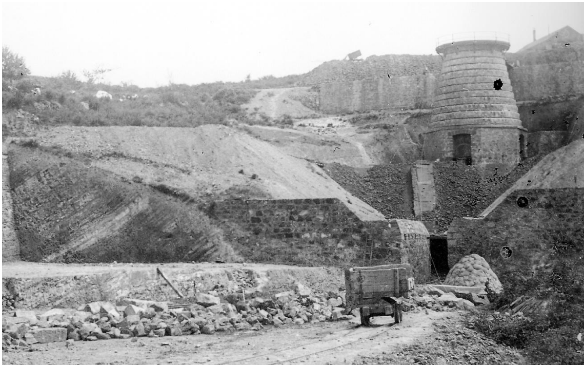
Figura 12. Fotografía del horno nº2 y su entorno de la mina Complemento en labores de construcción. 1903-1905. (Fuente: Fondo Mac Lennan del Archivo Municipal de Fotografías Antiguas Muskiz).
