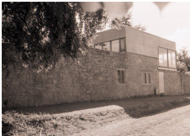
Figura 5. Fotografías de la fachada norte de Upper Lawn con piedra-escalón entre el suelo y la puerta de aluminio (izquierda) y la ventana perdida que se abre en el muro (debajo), agosto de 2016. (Fuente: Alberto Díez Gómez).
