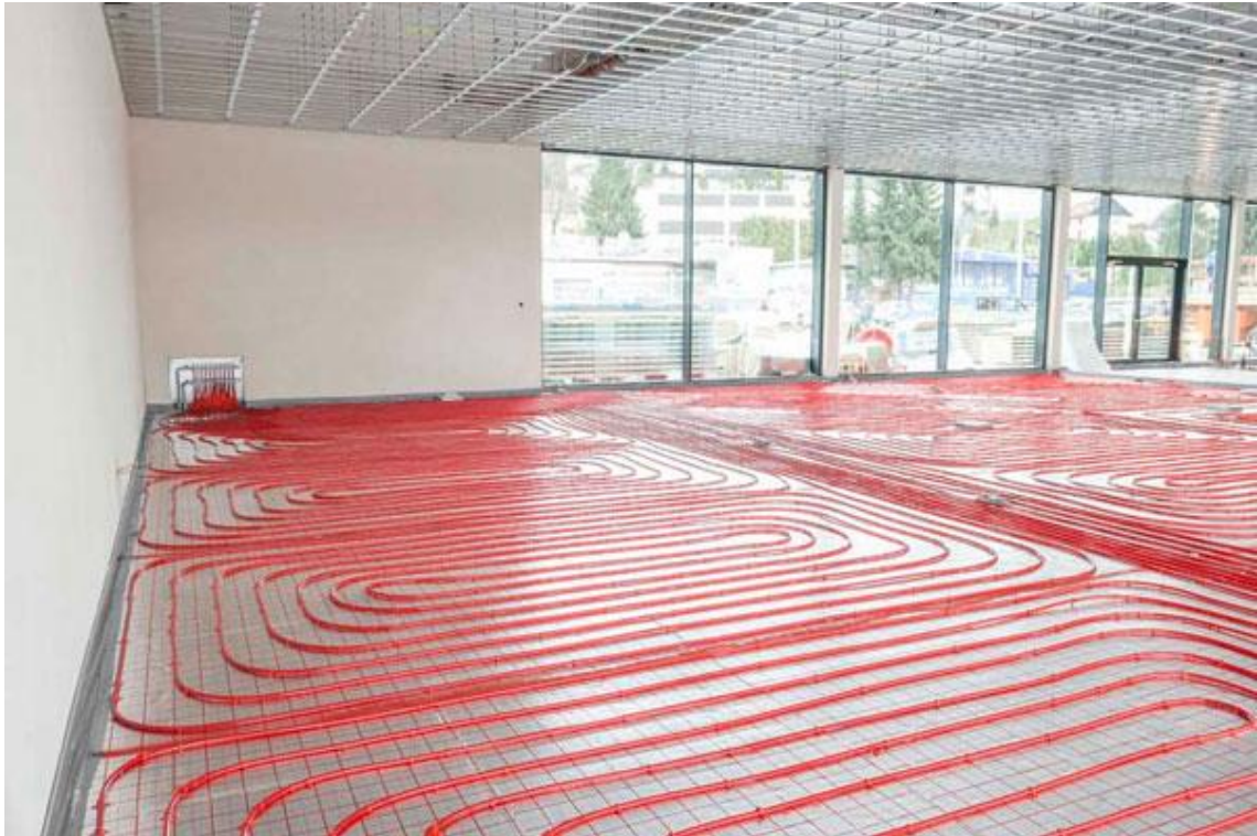
Fig.5 Sistema de suelo radiante. [28]
