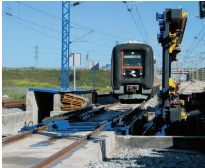
Figura 1.3: Tren en el cambiador de Zaragoza a punto de pasar del ancho internacional al ancho ibérico. (Foto: Sergio López Lara).
