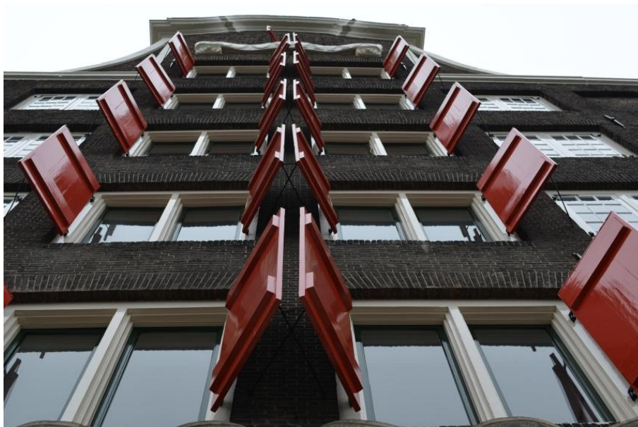
Fig. 1.16: Edificio con contraventanas en Dordrecht (Países Bajos)
