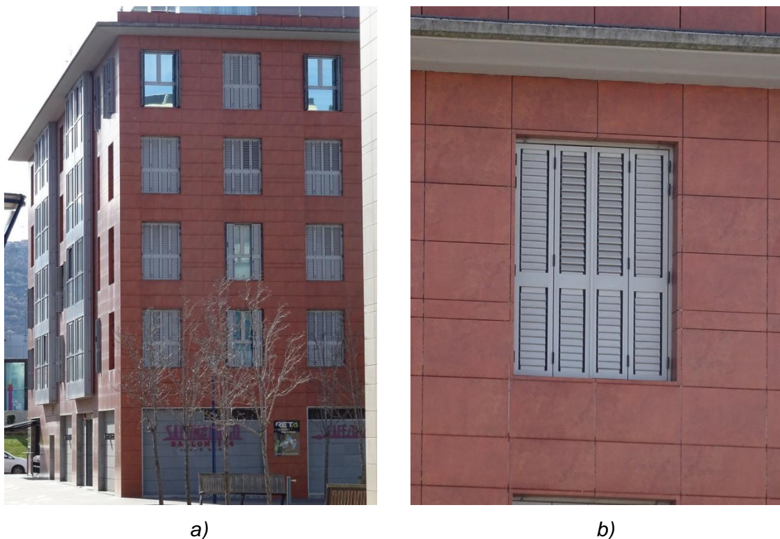
Fig. 1.19: Edificio residencial colectivo 2 en Portugalete (Bizkaia) a) Vista general; b) Detalle hueco de fachada
