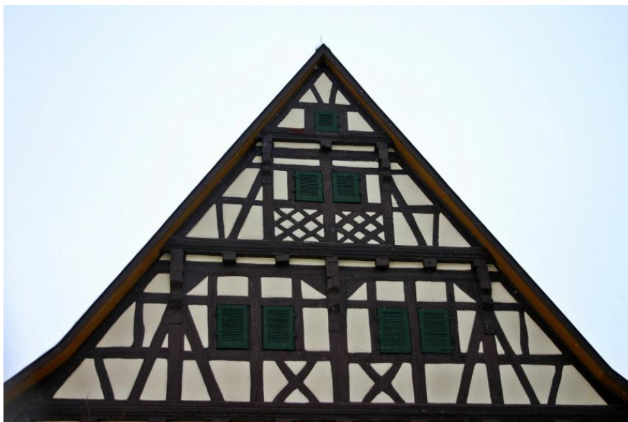
Fig. 1.9: Edificio con contraventanas en Swabia (Alemania)
