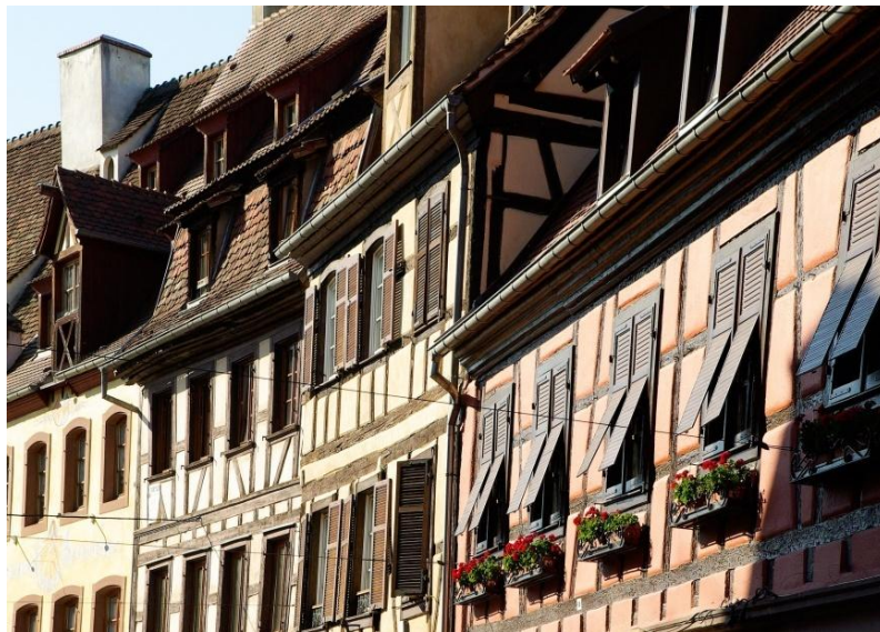
Fig. 1.13: Edificios con contraventanas en Obernai (Francia)
