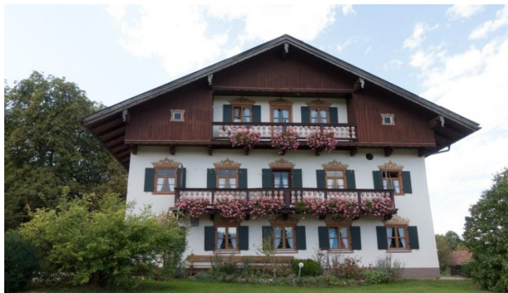
Fig. 1.12: Edificio con contraventanas en Alta Baviera (Alemania)
