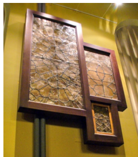
Figura 19 Ventana restaurada con láminas de moscovita, un mineral de mica.
