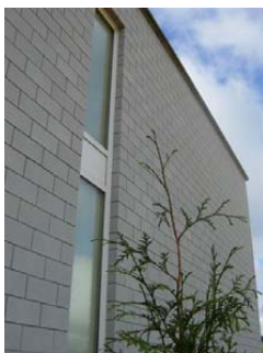
Figura 15 Fachada de bloques de hormigón © ANDECE.
