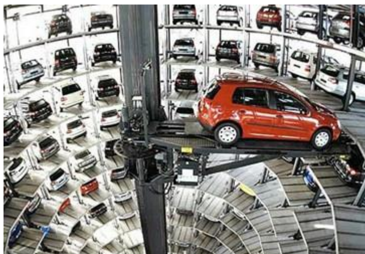
Irudia. 12. Egitura zirkularra duen parking robotizatua
