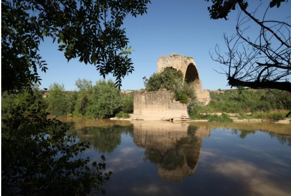
Fig. 2.- Arco de la margen izquierda (vista aguas abajo) tomada desde la orilla opuesta.
