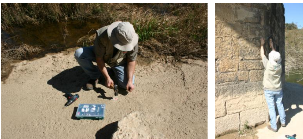
Fig. 7.- Señalización mediante clavos en el terreno y sobre los muros del puente.
