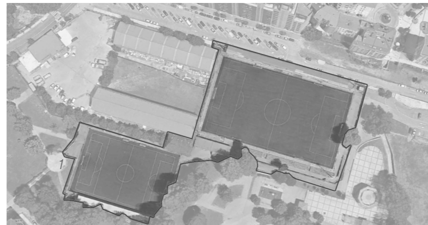
LUTXANAKO SORTING FCren INSTALAZIOAK
