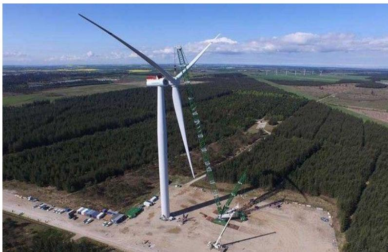
**Figura 39. Plataforma de montaje de un aerogenerador.**
