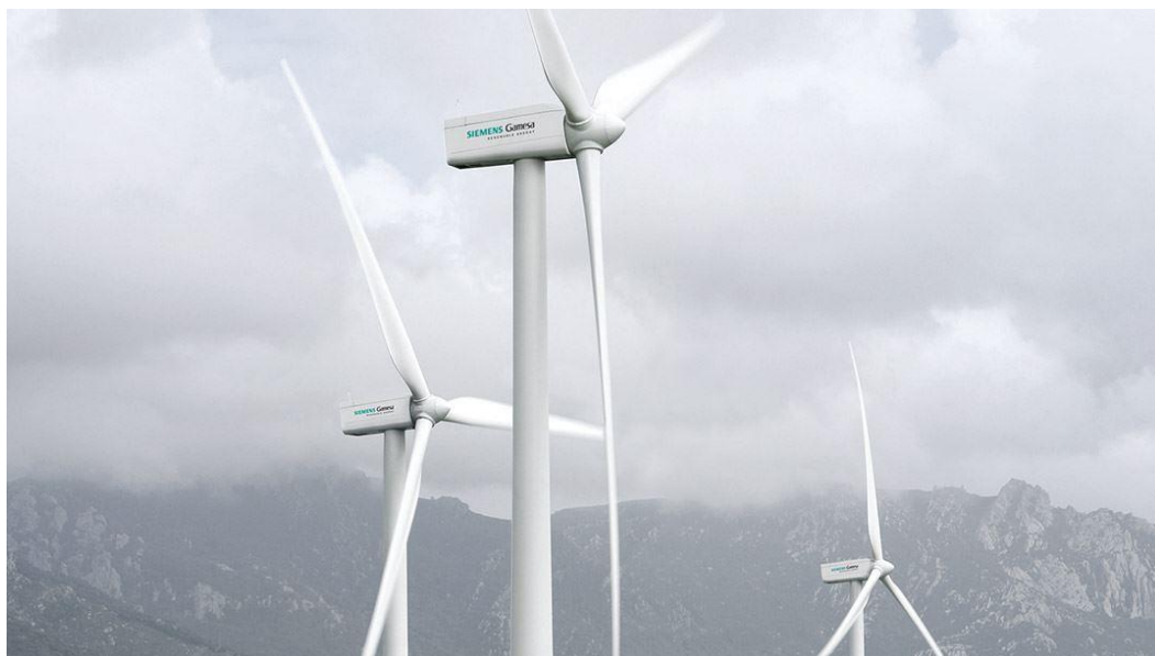
25.Irudia. SG114-2,5 MW deituriko sorgailu eolikoak [12].
