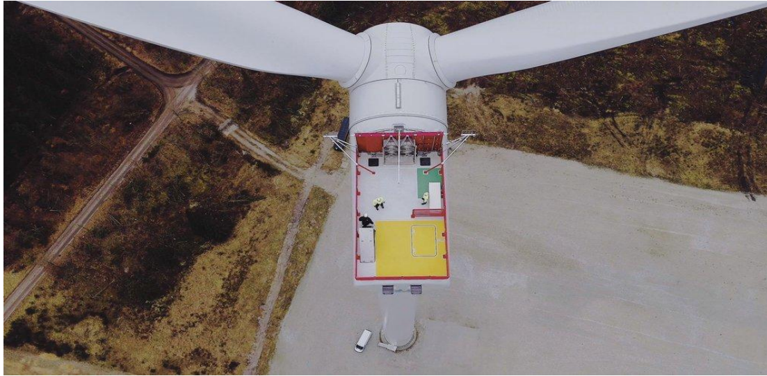
26. Irudia. Sorgailu eolikoaren barnean kokatzen diren transformazio zentroak [13].
