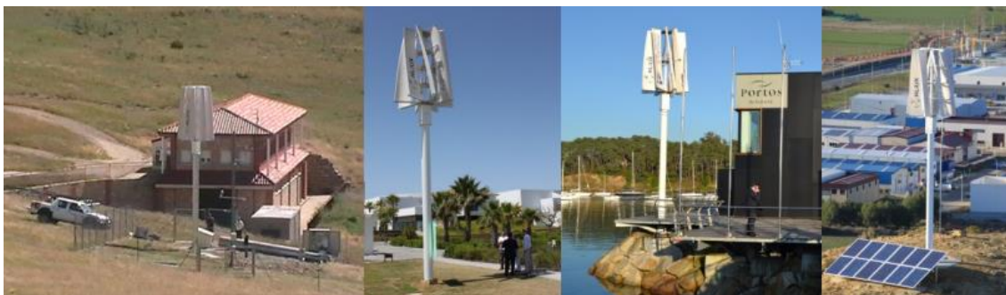
Ilustración 15. Modelos de Kliux Energies instalados en el ámbito urbano y rural.
