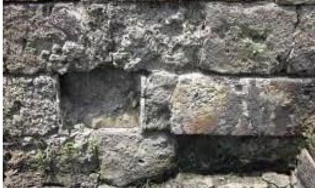
*Ilustración 19. Deterioro de dovelas de piedra.
