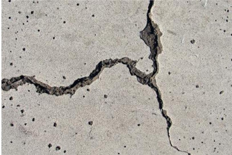
*Ilustración 22. Fisuras como consecuencia de la retracción hidráulica del hormigón.
