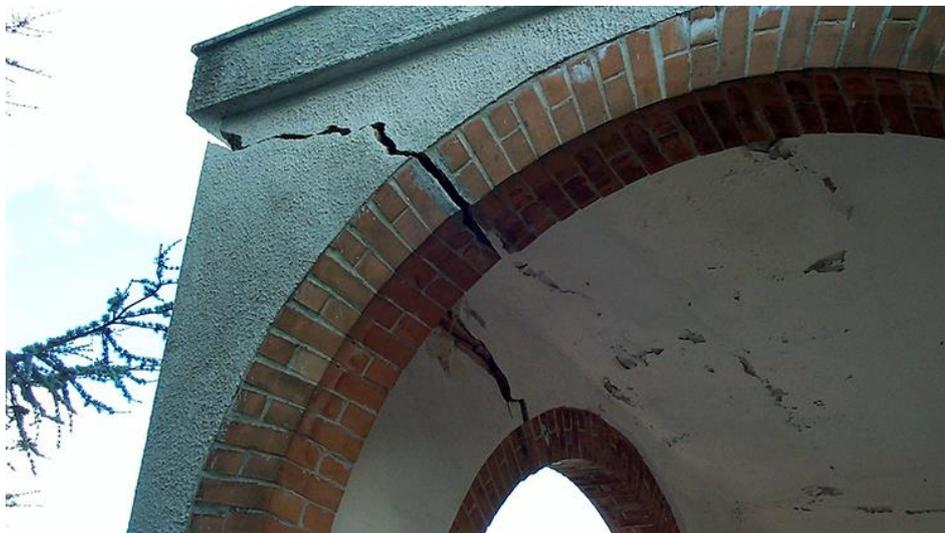
*Ilustración 18. Fisura como consecuencia de un error de asentamiento.*
