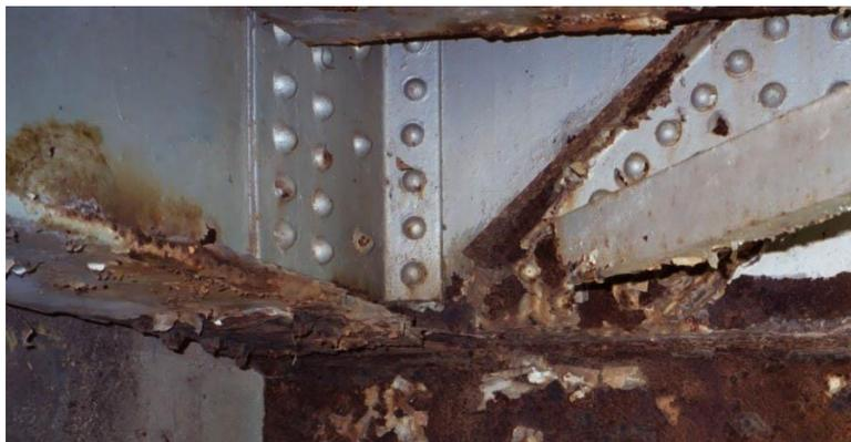
*Ilustración 27. Efectos de la corrosión en la unión de barras.
