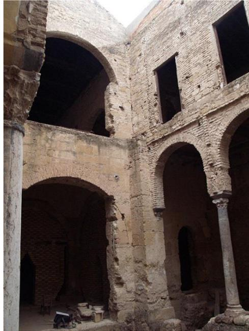
*Ilustración 23. Defectos en la unión del arco con el pilar y arco contiguo que lo sustentan.*
