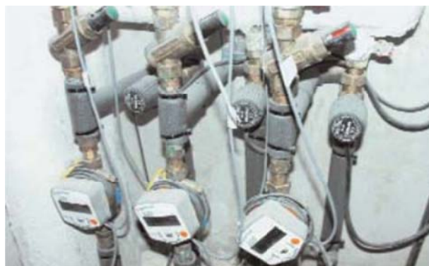
Ilustración 30: Contadores individuales en una comunidad
