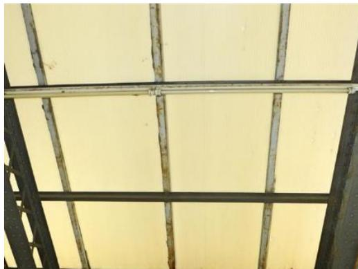
Ilustración 21: Corrosión en los perfiles de sujeción del cerramiento
