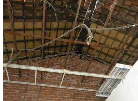
Ilustración 24:a) Entablado perimetral, b) Tablero de aglomerado
