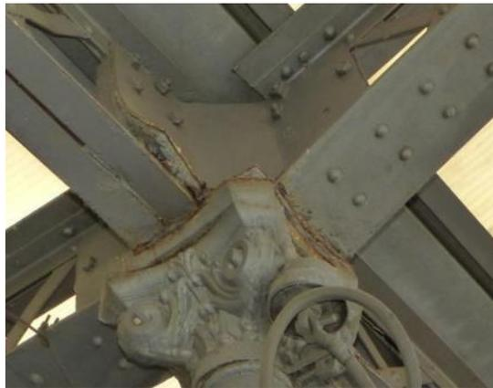
Ilustración 20: Corrosión de uno de los nudos
