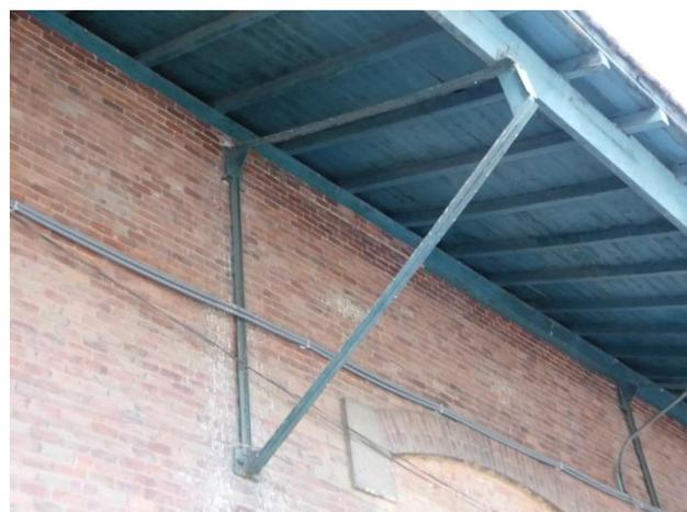
Ilustración 8: Disposición de ménsulas
