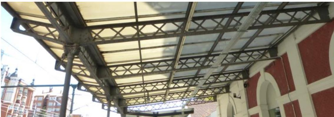
Ilustración 13: Vigas Transversales
