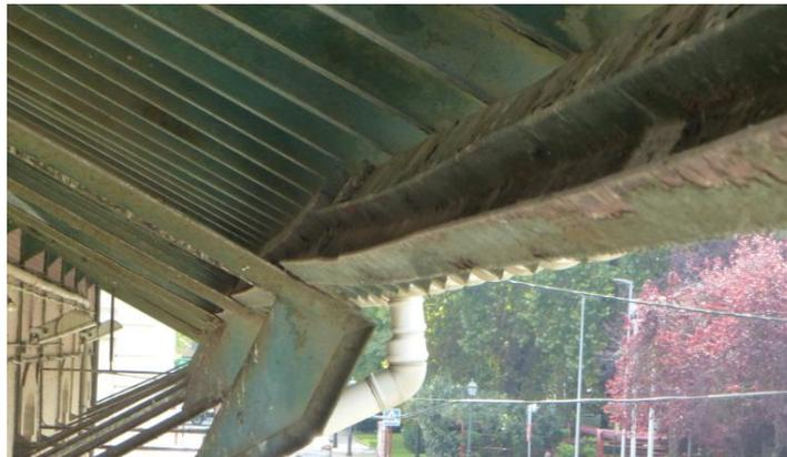
Ilustración 44: Deformaciones en la dirección de la cubierta
