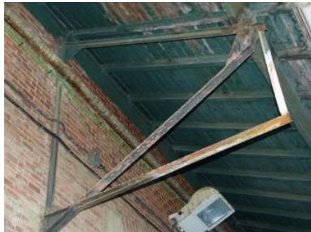
Ilustración 18: Unión de elemento metálico sobre ménsula
