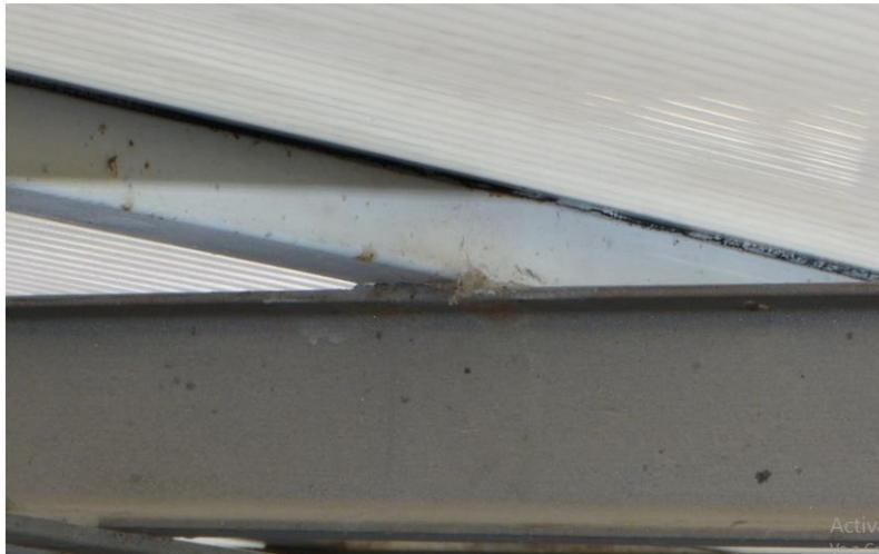
Ilustración 11: a) Cerramiento de policarbonato b) Soldadura del perfil de sujeción sobre la correa
