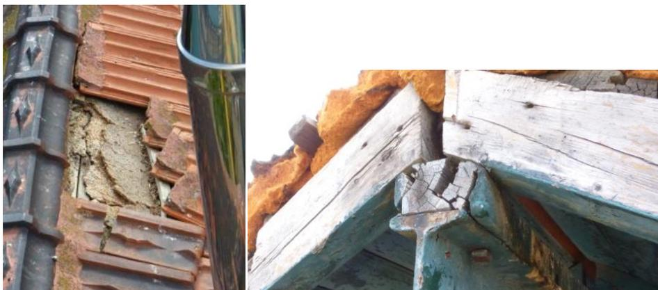
Ilustración 15: Grietas sobre entablados
