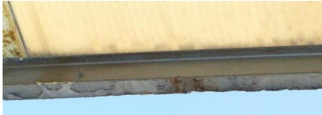
Ilustración 19: Corrosión en la correa de mayor exposición
