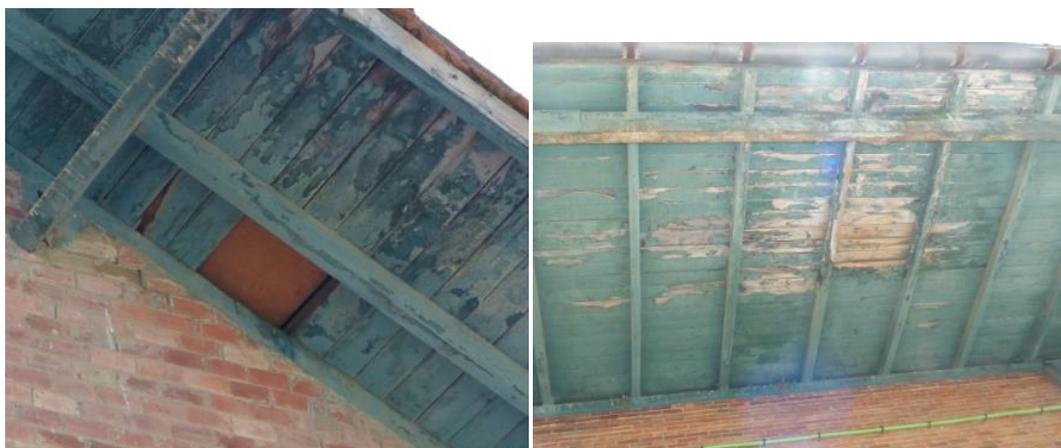
Ilustración 16: Ausencia y deterioro del entablado perimetral
