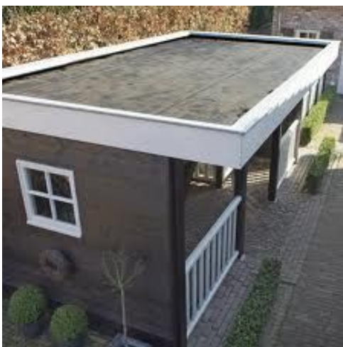
Ilustración 1. Cubierta plana ( http://cort.as/-LI2- )
