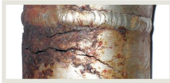
Ilustración 35. Corrosión bajo tensión ( http://cort.as/-LLBd )
