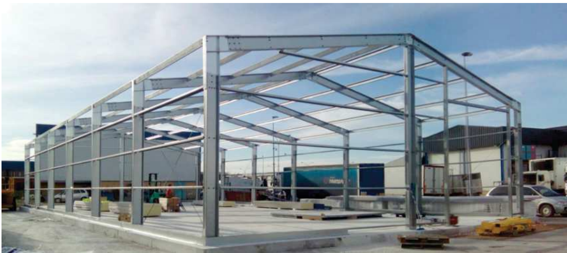
Imagen 6: Ejemplo de estructura metálica.
