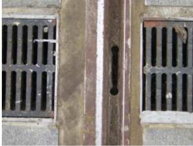
Imagen18: Ejemplo de drenaje del rail.
