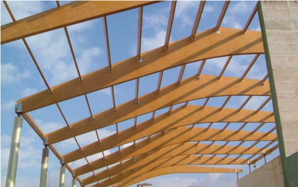
Imagen 5: Ejemplo de cubierta de madera laminada.
