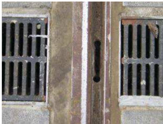
Imagen 2: Ejemplo de drenaje del rail.
