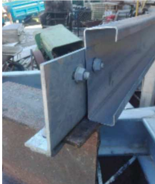
Imagen 11: Ejemplo de correa unida mediante ejión.
