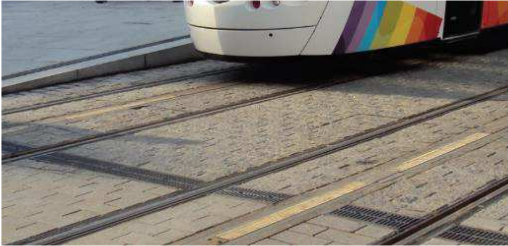
Imagen 1: Ejemplo de canal de drenaje.
