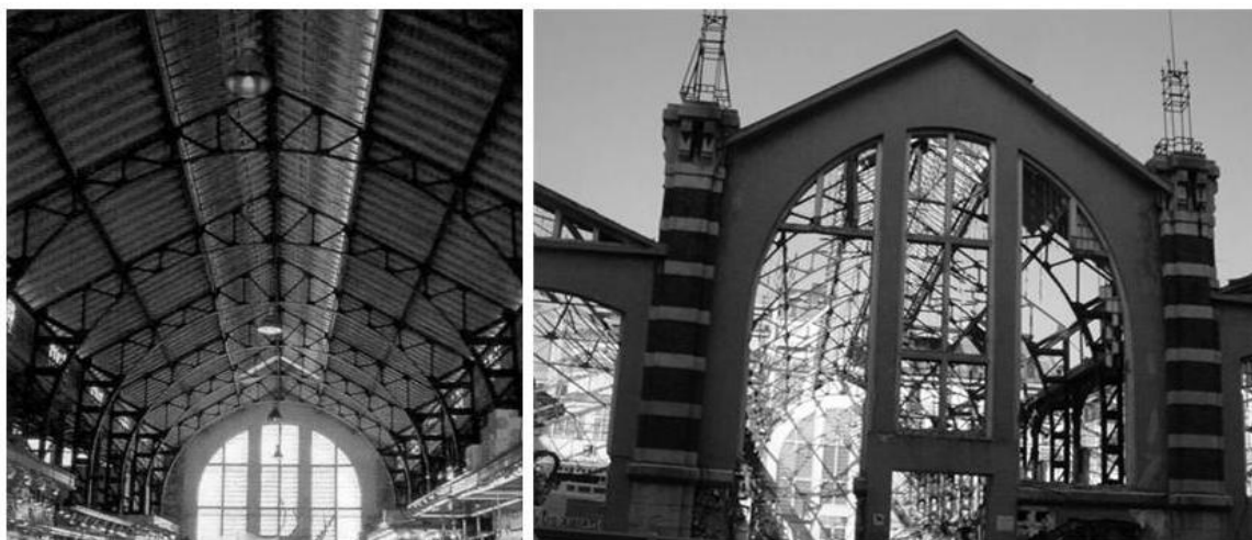
Fotografía 8: Interior del Mercado de San Martín. La imagen de la derecha corresponde al momento de su derribo en 2003, donde se puede apreciar la estructura metálica del edificio. 891
