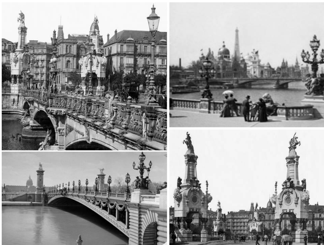
Fotografía 29: Puente María Cristina (superior izquierda e inferior derecha) de San Sebastián inaugurado en 1905 y el Puente Alejandro III de París.
