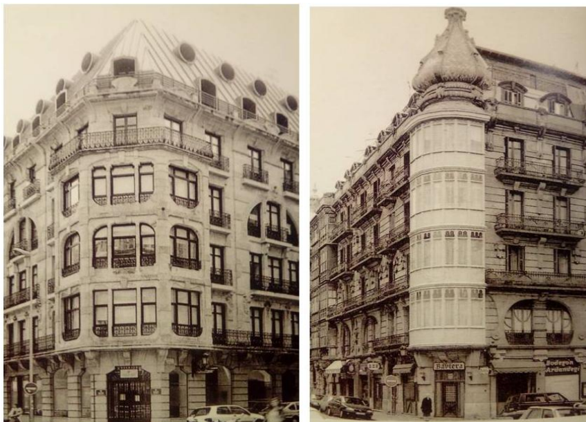
Fotografía 28: Edificios modernistas de Easo 10 (imagen izquierda) y Larramendi 3-5 (imagen derecha). 949
