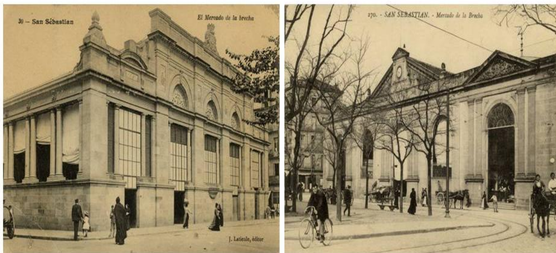
Fotografía 11: Mercado de la Bretxa; parte trasera y delantera. 899
