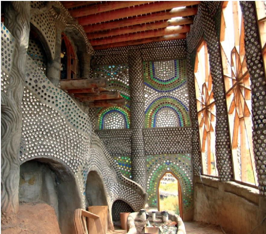
5. irudia. Birziklatutako lata eta botilak earthship en hormetan [19].
