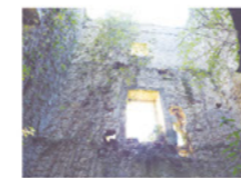
cara interior d e la torre
