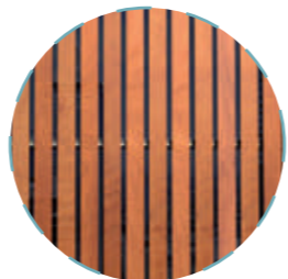
Uretako eraikindaren estalkia: Prodema panelak luzetara moztuta. Azpian panel osoak
