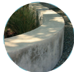
Hormigoizko baranda: 85 cm altuerako hormigof armatuzko babes hormatxoa
