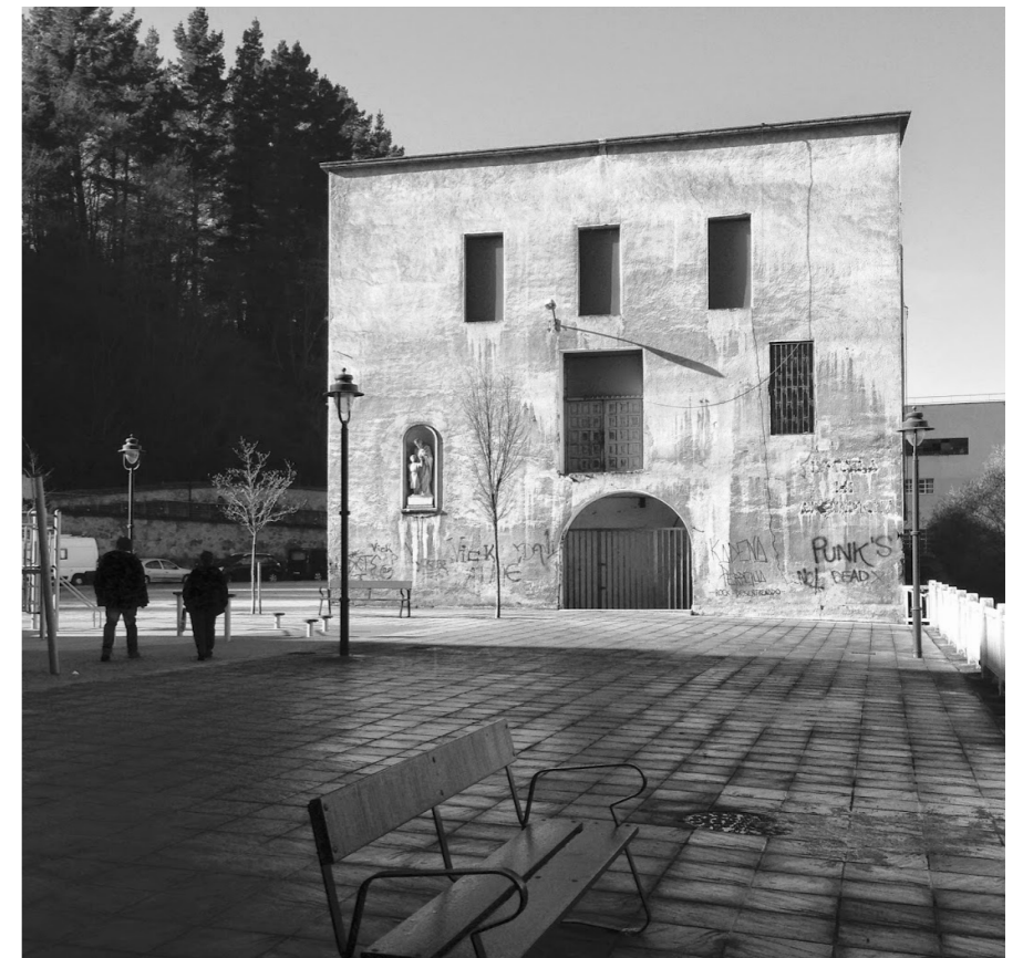
Ilustración 4: Fotografía de la ubicación del proyecto, vista frontal
