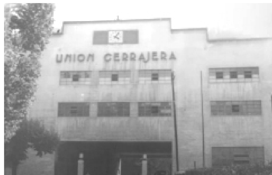
Ilustración 6: Edificio Unión Cerrajera
