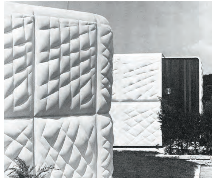
Detalles de las esquinas de los muros de hormigón blanco de la vivienda unifamiliar en la calle Camino alto 133, La Moraleja, alcobendas, Madrid, 1973. Miguel Fisac
