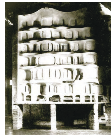
Para la realización de la fachada se construyó esta maqueta en yeso que se colocó en el sótano del edificio, de forma que los canteros pudiesen tomar medidas directamente sobre ella.
