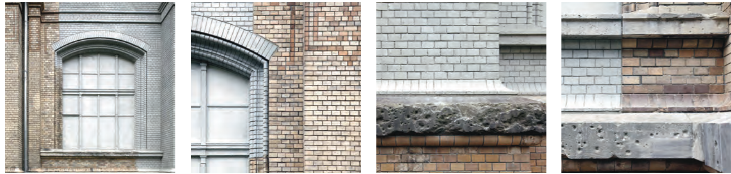
Tal vez una de las claves del proyecto sea su exquisitez en la ejecución de los detalles de la trabazón entre los restos originales y la nueva fachada.
