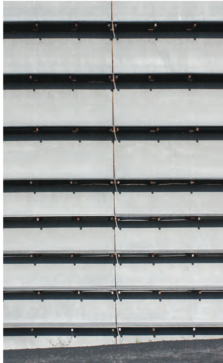
La esquina se resuelve de forma directa, sin piezas especiales, haciendo alarde de su materialidad industrial y en cierto sentido "low cost" de la envolvente.
