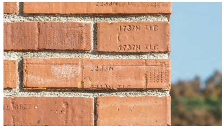
La potente textura de la Baker House se debe a la utilización de ladrillos, quemados, deformados, rotos y revirados, dentro de la fábrica.
