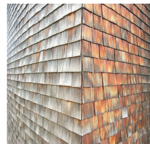
Las piezas de madera de la fachada muestran su origen artesanal. En la arista del acceso la diferente orientación de las dos fachadas marcan el paso del tiempo gracias al envejecimiento diferencial de ambas caras.
