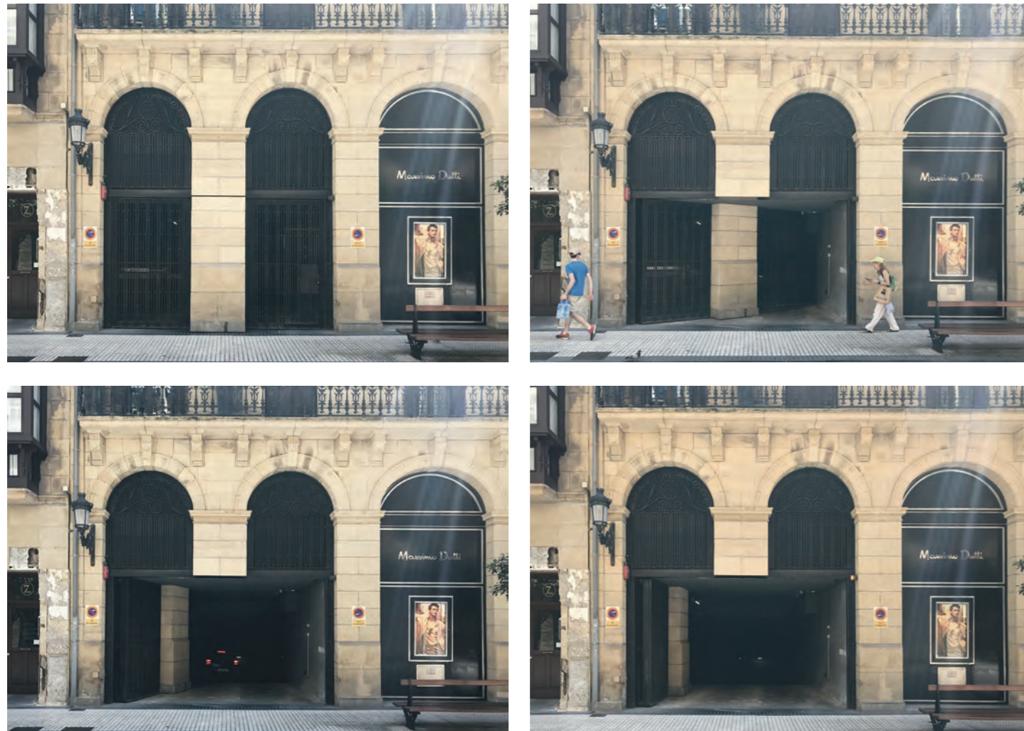
Acceso al garaje del inmueble de la calle Arrasate 9, Donostia-San Sebastián, Gipuzkoa, 2018.
