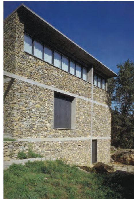
La malla de hormigón estabiliza estructuralmente y composítivamente el muro de piedra realizado en seco, lo que pone de manifiesto su función de relleno.
