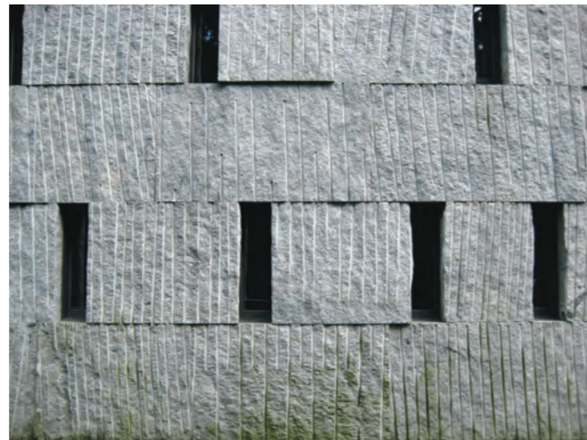
Los espacios entre los bloques apilados se transforman en los huecos que puntean las fachadas del edificio.
