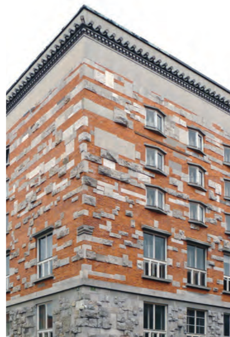
Las fachadas de la Biblioteca Nacional son un sumatorio de diferentes materiales, restos de antiguas edificaciones absorbidos en los muros de ladrillo del nuevo edificio público.
