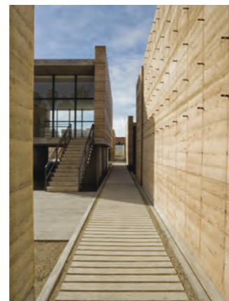
Los muros de tierra construidos mediante el sistema de tapial, son deudores de su sistema constructivo que requiere de la presencia de un encofrado.
