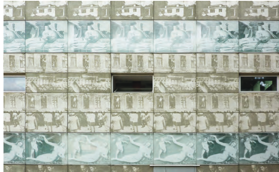
Biblioteca de Eberswalde, Alemania, finalizada en 1999. Herzog & de Meuron. Dos de los paneles de hormigón serigrafados reproducen la fotografía de Frieda Schulze, el 25 de septiembre de 1961 huyendo de su apartamento, en la primera planta del número 29 de la calle Bernauerstrasse para evitar quedar encerrada por el muro de Berlín, que había comenzado a levantar el mes anterior.
