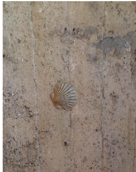
Conchas introducidas por Le Corbusier en el encofrado de los muros del portal de acceso a la Unité d'Habitation de Marsella hacia el año 1948.
