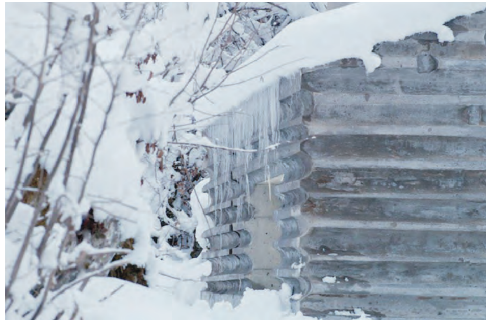
La estructura original construida mediante el apilamiento ortogonal de troncos ha dejado su huella impresa en las formas del hormigón, generando una especie de memoria basada en la ausencia de lo que alguna vez fue.
