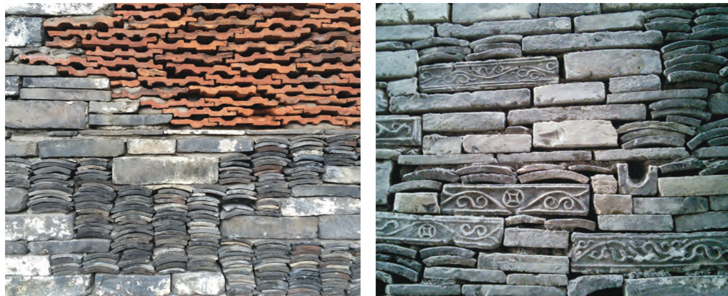
Tejas de diferentes tipos, ladrillos, cornisas, elementos decorativos, e incluso canalones de piedra se amontonan trabando su geometría y construyendo los muros del nuevo museo.
