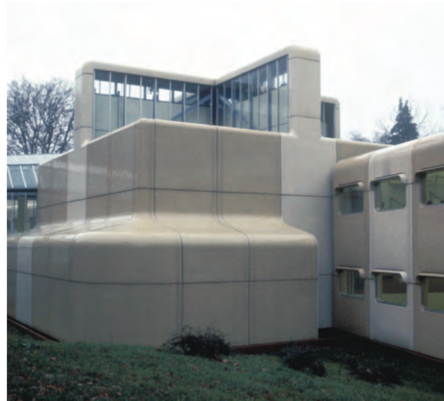
La fachada plástica del edificio para Olivetti recuerda a las carcasas plásticas de las máquinas de escribir que la propia empresa fabrica.
