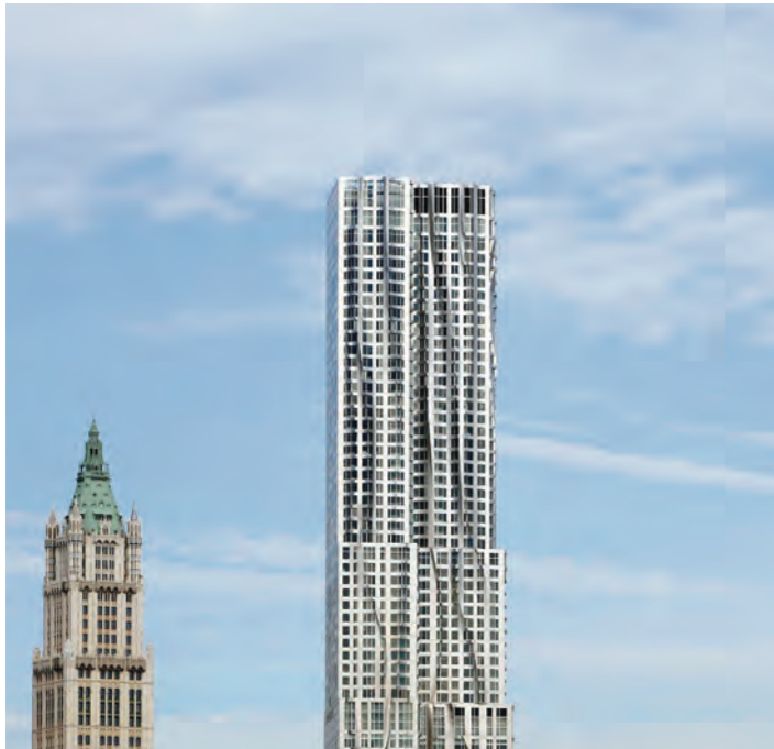
La fachada principal de la Beekman Tower queda caracterizada por el movimiento otorgado a su superficie, que parece plegarse por efecto de un viento rasante que la ondula caprichosamente.
