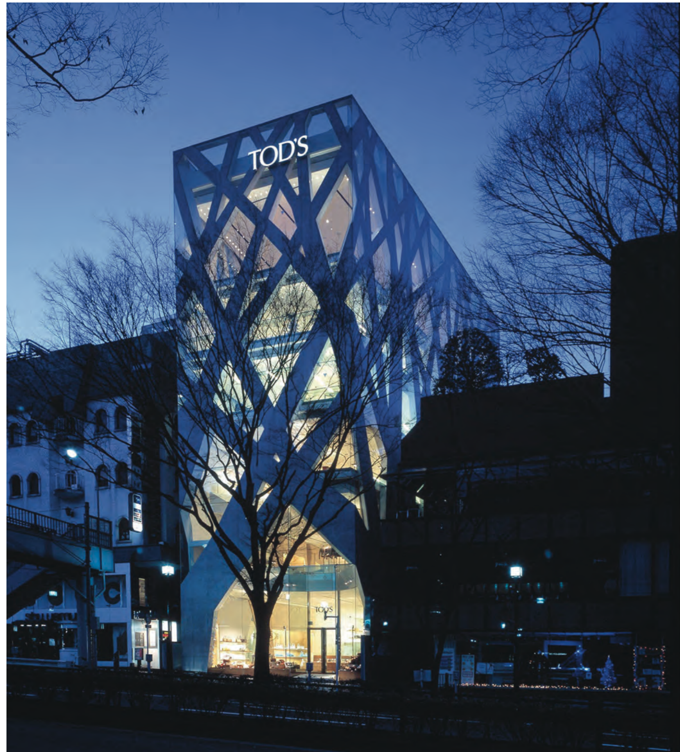
Vista nocturna. Edificio Tod's Omotesando, Aoyama, Tokio, Japón, 2002-04. Toyo Ito
