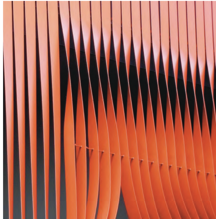
La ejecución de la fachada mediante grandes cintas metálicas permite que éstas se vayan deformando, adaptando geometrías que facilitan las entradas de luz así como los pasos hacia el interior del edificio.
