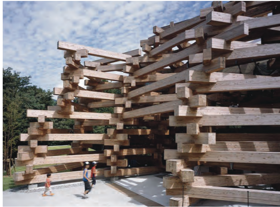
La boca de acceso surge girando hacia el interior las piezas que ocupaban esa posición
