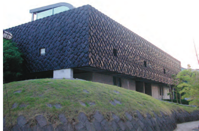
Muro de hormigón armado negro de las Nexus World Housing, OMA, Fukuoka 1991
