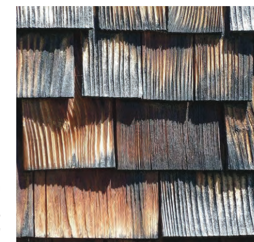
Las piezas de madera de la fachada muestran su origen artesanal. En la arista del acceso la diferente orientación de las dos fachadas marcan el paso del tiempo gracias al envejecimiento diferencial de ambas caras.
