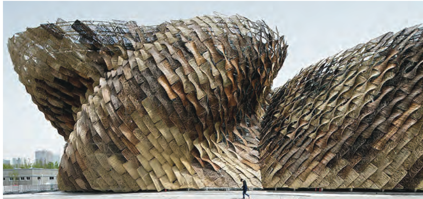
Las curvaturas y ondulaciones controladas mediante sistemas informáticos, contrastan con la materialidad artesanal a base de juncos y mimbres que compon las escamas de la fachada, siguiendo el ejemplo de la cestería tradicional china y española.
