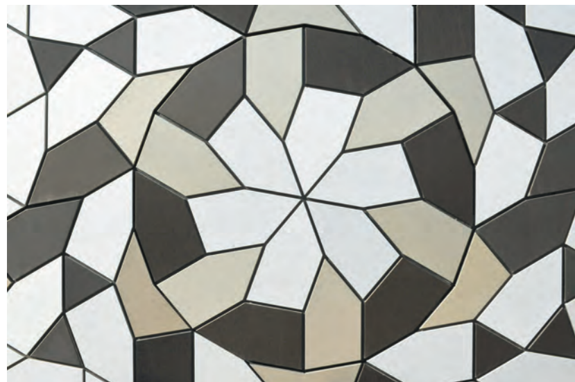
Inspirados en los rosetones góticos, el diseño de Foreign Office Architects construye una fachada revestida de azulejos con un patrón de teselación no periódico. Ese revestimiento utilizaba 28,000 losetas de aluminio anodizado. Los tres azulejos, uno triangular y dos pentagonales irregulares, varían de tamaño y de color dependiendo de la ubicación designada en relación a las ventanas.
