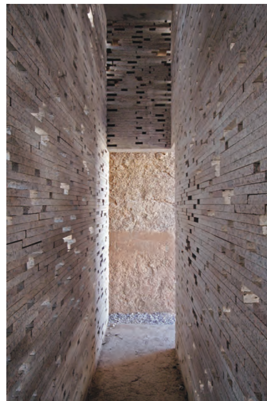
El sistema constructivo, mediante lajas de piedra, rememora la construcción de los muros tradicionales ejecutados con tongadas de tapial y verdugadas de ladrillo, destilando la horizontalidad de aquellos muros.
