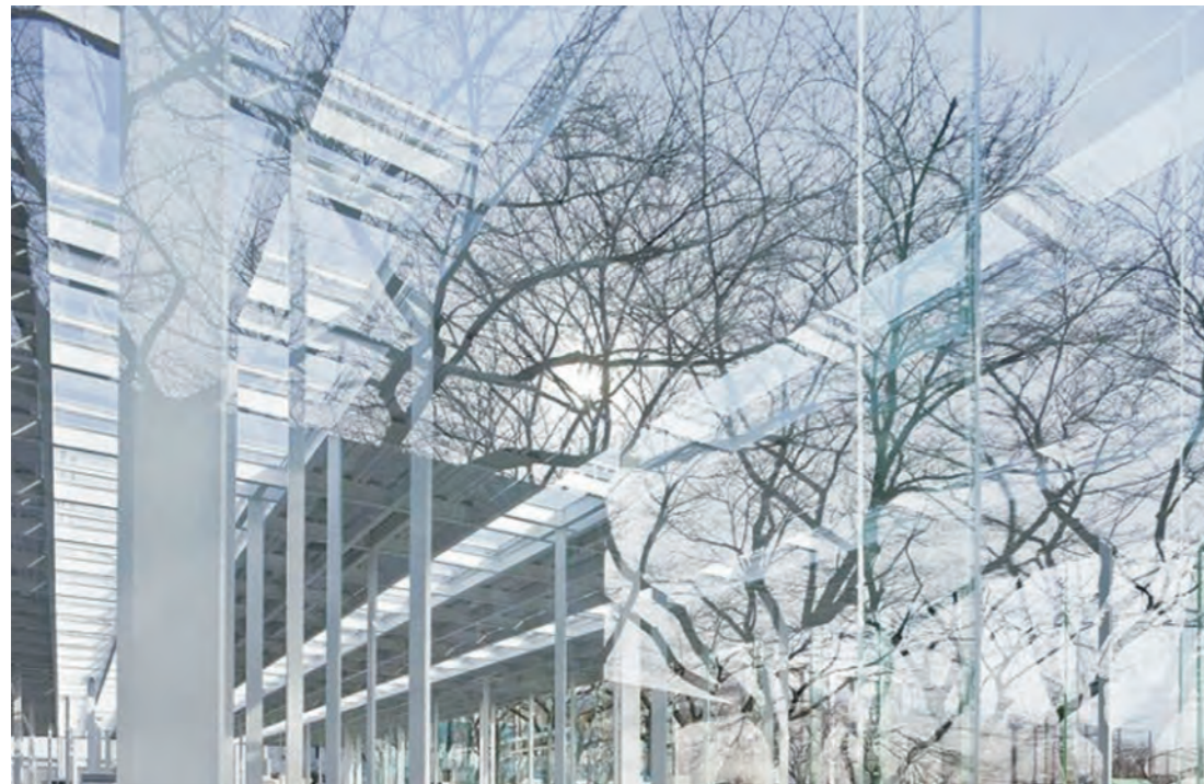
La fachada del KAIT, Pabellón del Instituto Tecnológico Kanagawa de Junya Ishigami, es de una ligereza extrema; apenas una lámina de vidrio. La materialidad de esa lámina mínima queda prácticamente supeditada al reflejo y a las sombras que los árboles construyen sobre la misma.
