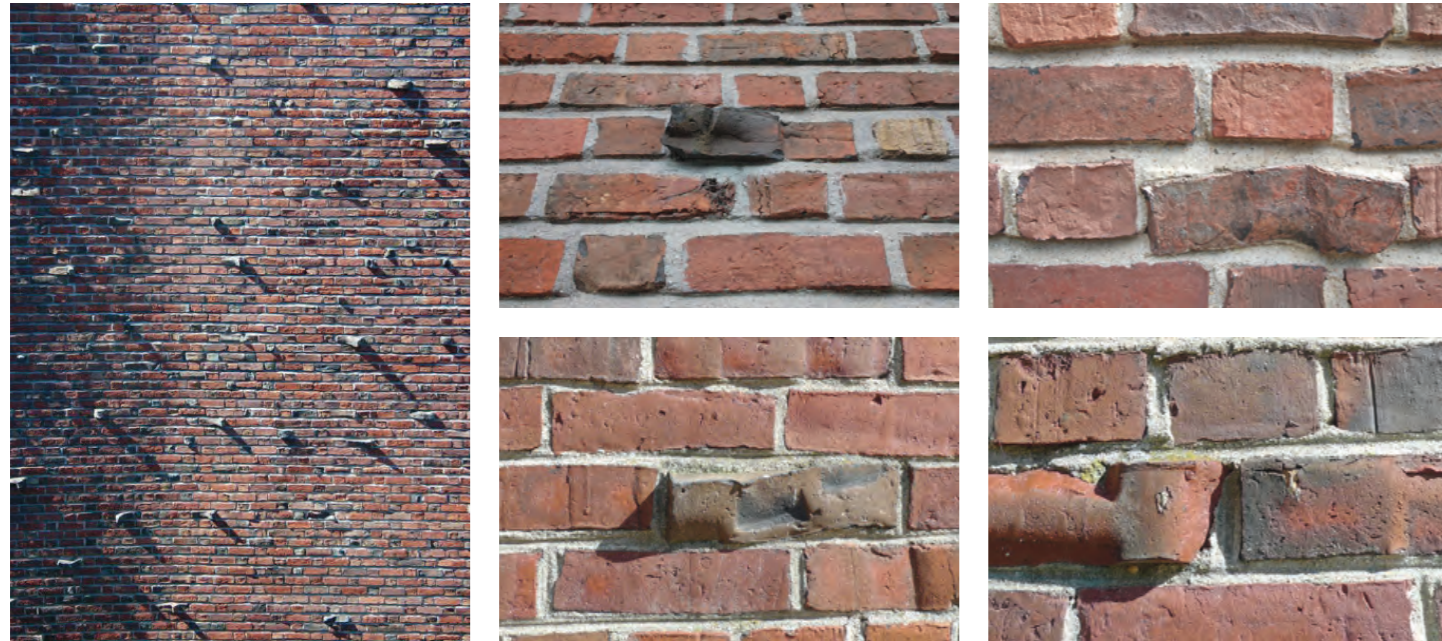
La potente textura de la Baker House se debe a la utilización de ladrillos, quemados, deformados, rotos y revirados, dentro de la fábrica.
