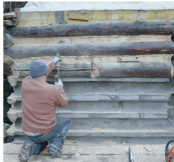
La obra se inició con la ejecución de diferentes trabajos de carpintería para el preparado de la antigua estructura de madera y su adaptación a la nueva función de encofrado.
