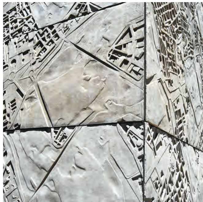
Vista del Palacio de Congresos y Exposiciones en Mérida, España, 2004, obra de Nieto y Sobejano. Y detalle de los prefabricados de hormigón realizados con la textura de los bajorrelieves realizados por la escultura Esther Pizarro.
