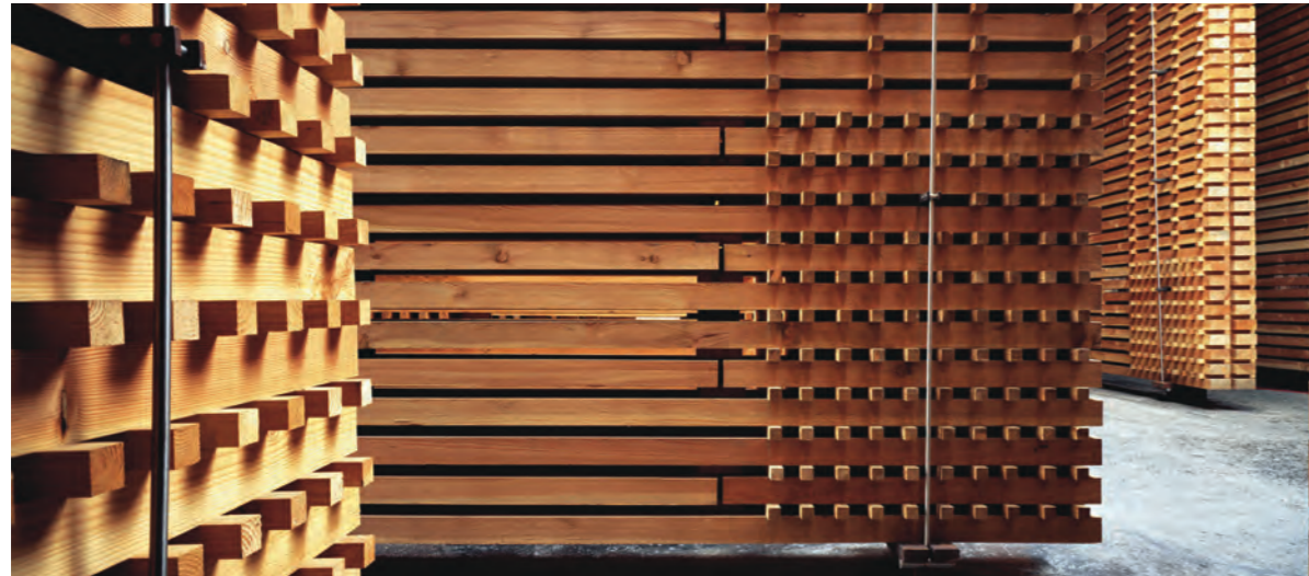
Los muros del Pabellón Suizo en la Exposición Internacional de Hannover adoptan la imagen de las construcciones efímeras con las que los aserraderos helvéticos apilan las escuadrías de madera para su secado.
