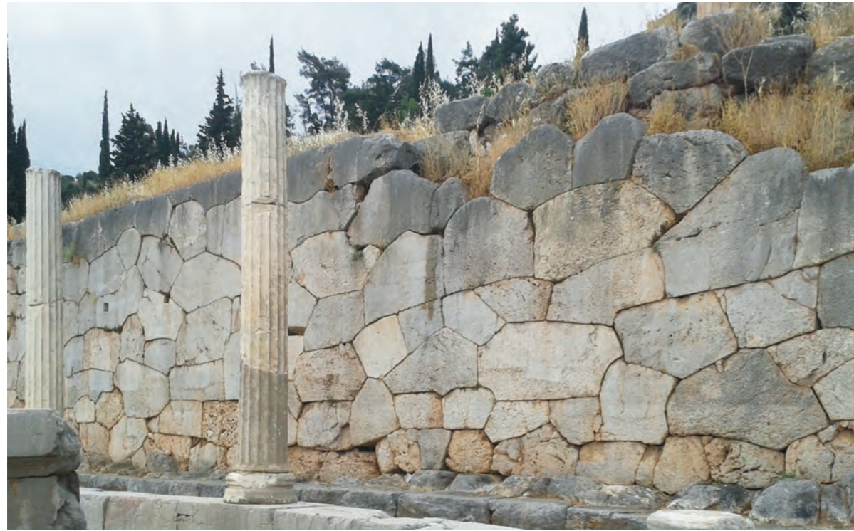
Muro poligonal del Santuario de Delfos, Grecia. El muro fue construido después de la destrucción del primer templo de Apolo en 548 a. C., para contener la terraza, sobre la que se va a edificar el nuevo templo.
