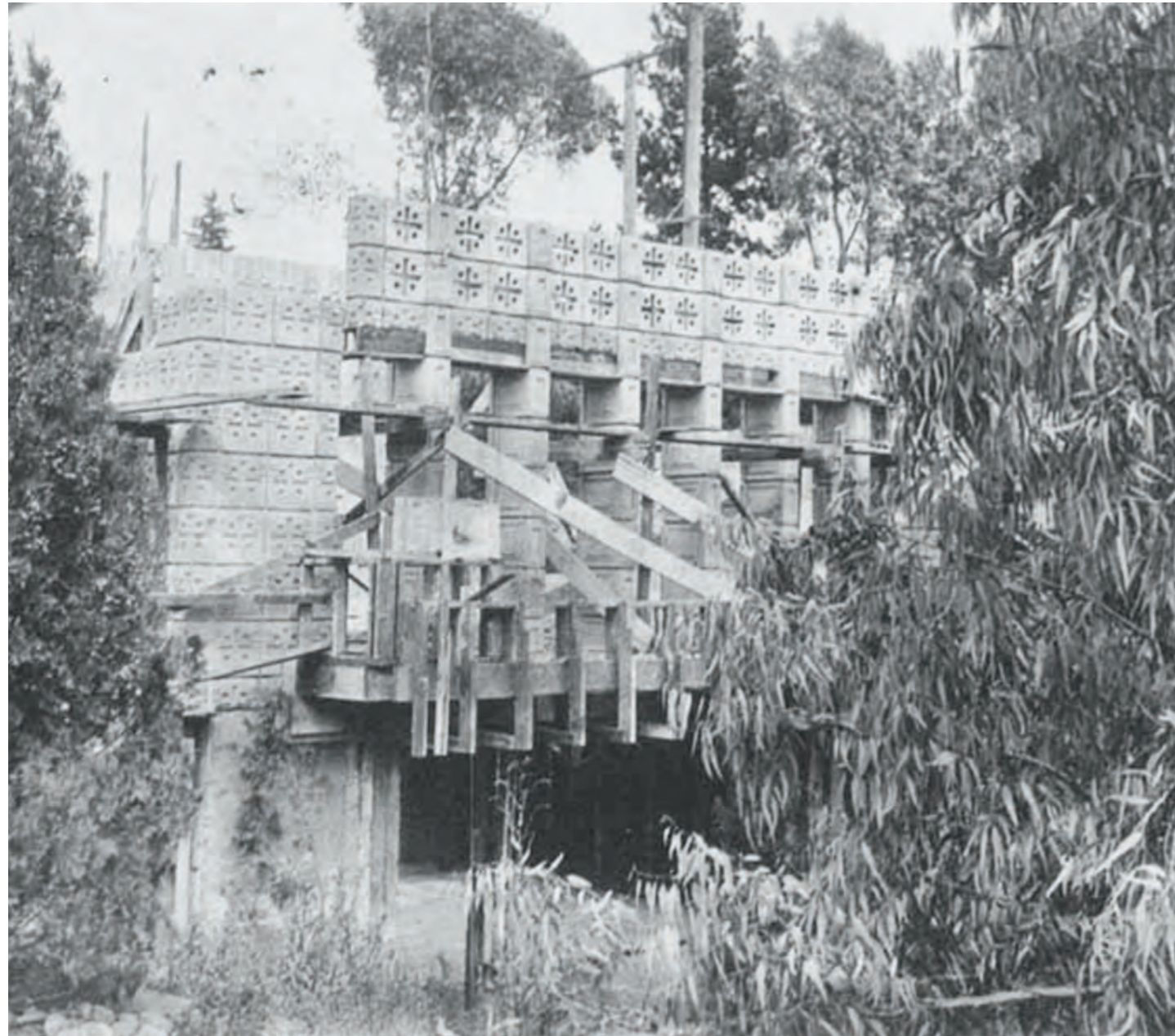
Fotografía de la Casa Millard "La Miniatura" en Pasadena, Los Ángeles, durante su construcción en 1923.
