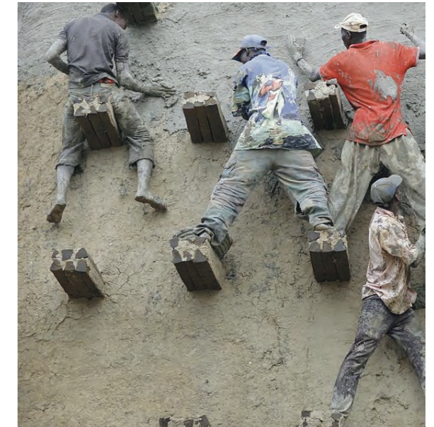
Las piezas de madera que rigidizan los muros se utilizan además como sistema de andamiaje para poder mantener adecuadamente la envolvente de barro de la mezquita.
