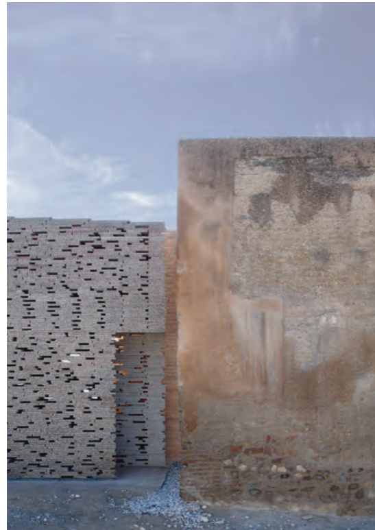
Los muros se vuelven porosos, haciendo gala de su construcción en seco que reivindica el apilamiento como un sistema primario, básico y por lo tanto primitivo, arcaico, en cierto modo atemporal.
