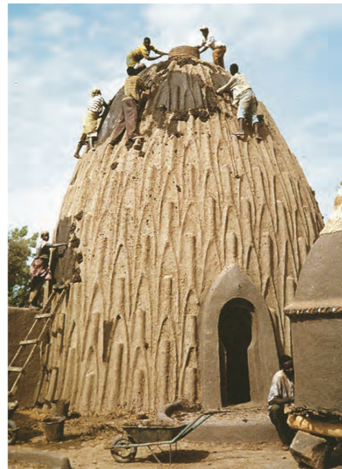
La arcilla requiere un mantenimiento constante. La ornamentación de la fachada a modo de mazorca de maíz, tiene además una finalidad funcional, al servir como andamiaje fijo para acceder a la parte alta de las estructuras.
