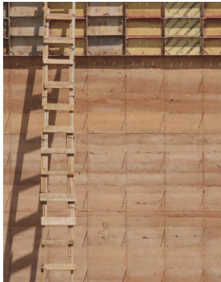
Los muros de tierra construidos mediante el sistema de tapial, son deudores de su sistema constructivo que requiere de la presencia de un encofrado.
