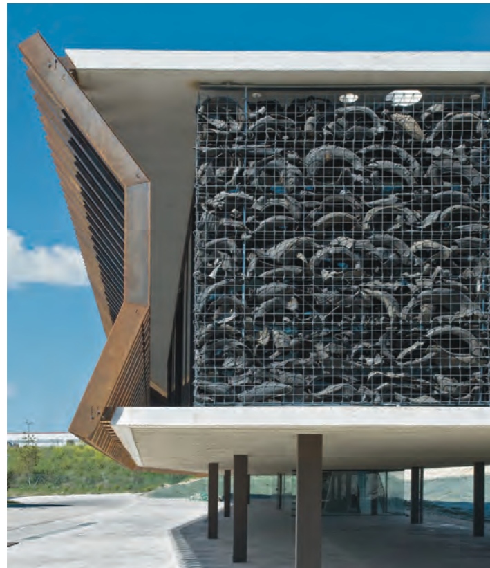
Fachada lateral y vista desde el interior de los gaviones realizados con neumáticos reciclados en el edificio de la sede de Audenasa, Noain, 2009
