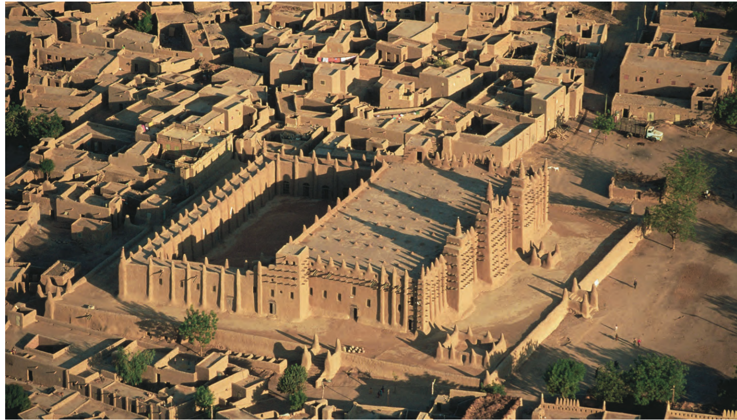
Todo el paisaje urbano está dominado por el color terroso de la arcilla, único material disponible en la región. La gran mezquita destaca por su dimensión sobre la trama irregular de la ciudad de Djenné en Mali. La estructura interna de madera presente en los muros, puntea la fachada dibujando una trama geométrica que ordena y da unidad al conjunto.
