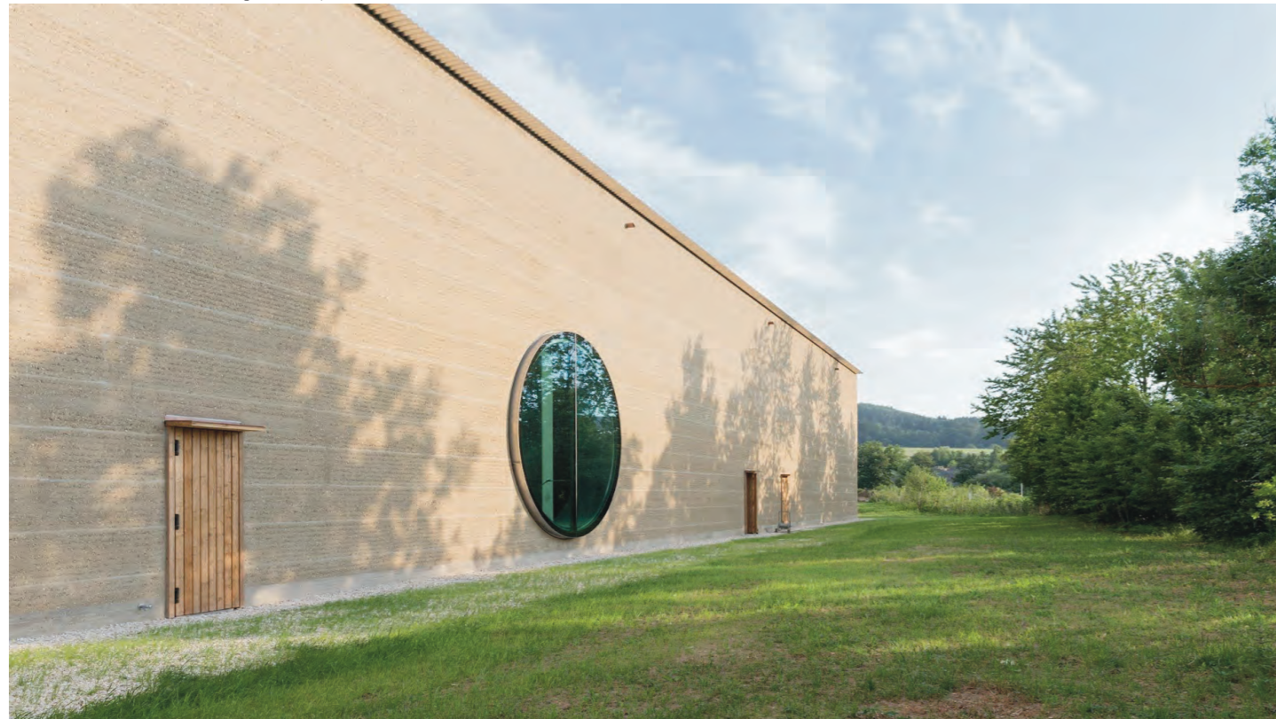
El Kräuterzentrum se implanta como un sólido abstracto y rígidamente en el paisaje, en el que la masa terrosa de su envolvente queda matizada por las líneas horizontales que la recorren, fruto de su construcción a base de tongadas compactadas.
