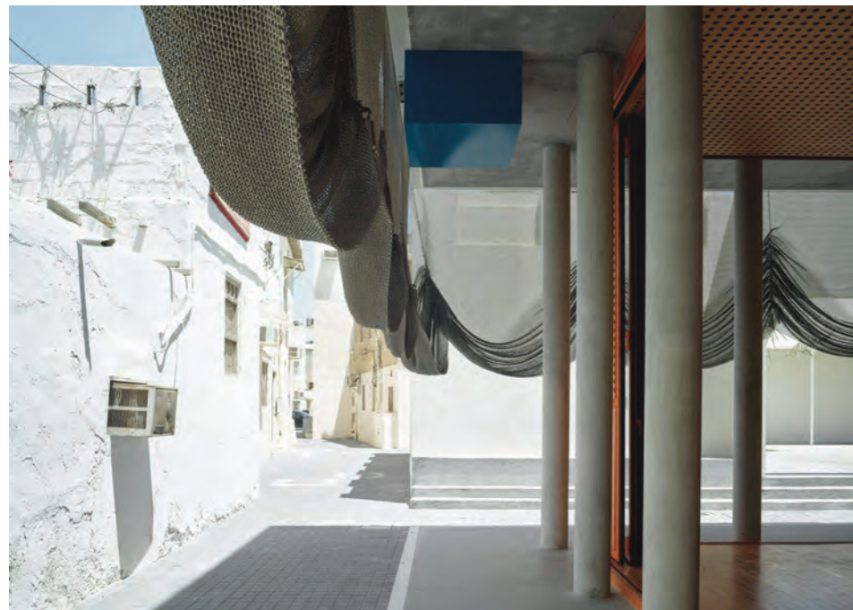
Una cortina de eslabones metálicos que opera como una cota de malla, concentra la fuerza formal del edificio, y por otro lado toda la potencia discursiva de estas arquitecturas, construidas por el estudio Office Geers & Severen, en Bahrein en el año 2017.
