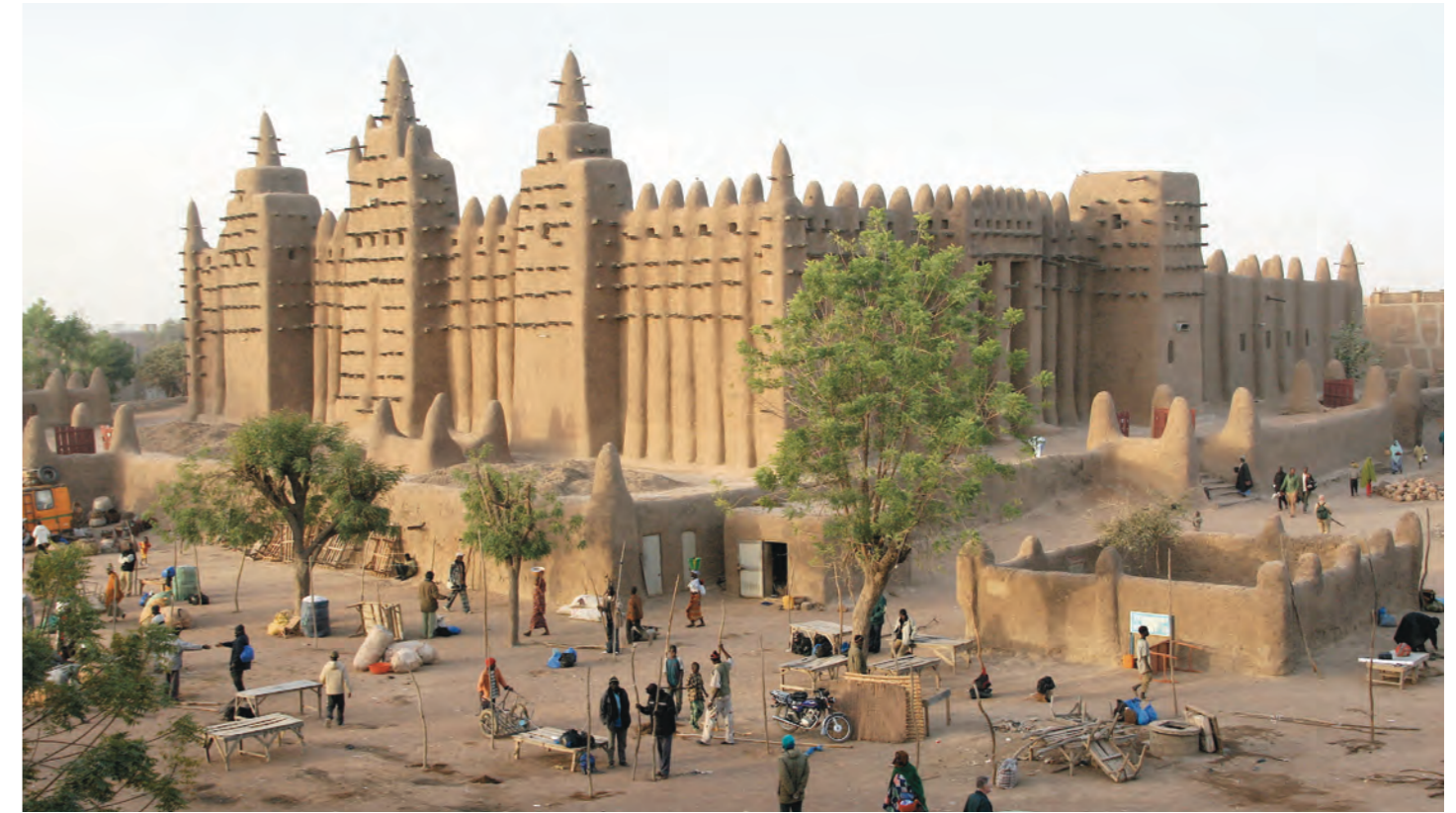
Las piezas de madera que rigidizan los muros se utilizan además como sistema de andamiaje para poder mantener adecuadamente la envolvente de barro de la mezquita.
