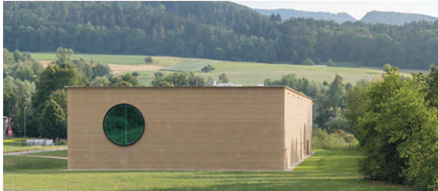
El Kräuterzentrum se implanta como un sólido abstracto y rígidamente en el paisaje, en el que la masa terrosa de su envolvente queda matizada por las líneas horizontales que la recorren, fruto de su construcción a base de tongadas compactadas.
