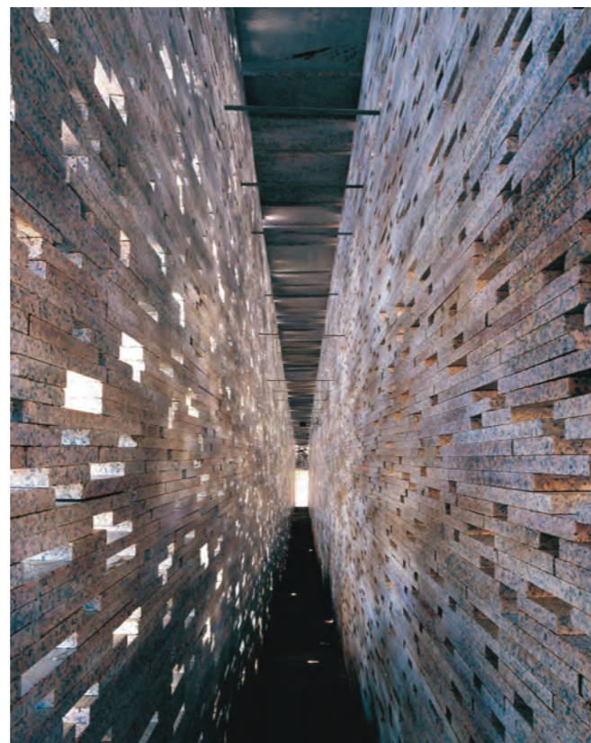
El sistema constructivo, mediante lajas de piedra, rememora la construcción de los muros tradicionales ejecutados con tongadas de tapial y verdugadas de ladrillo, destilando la horizontalidad de aquellos muros.
