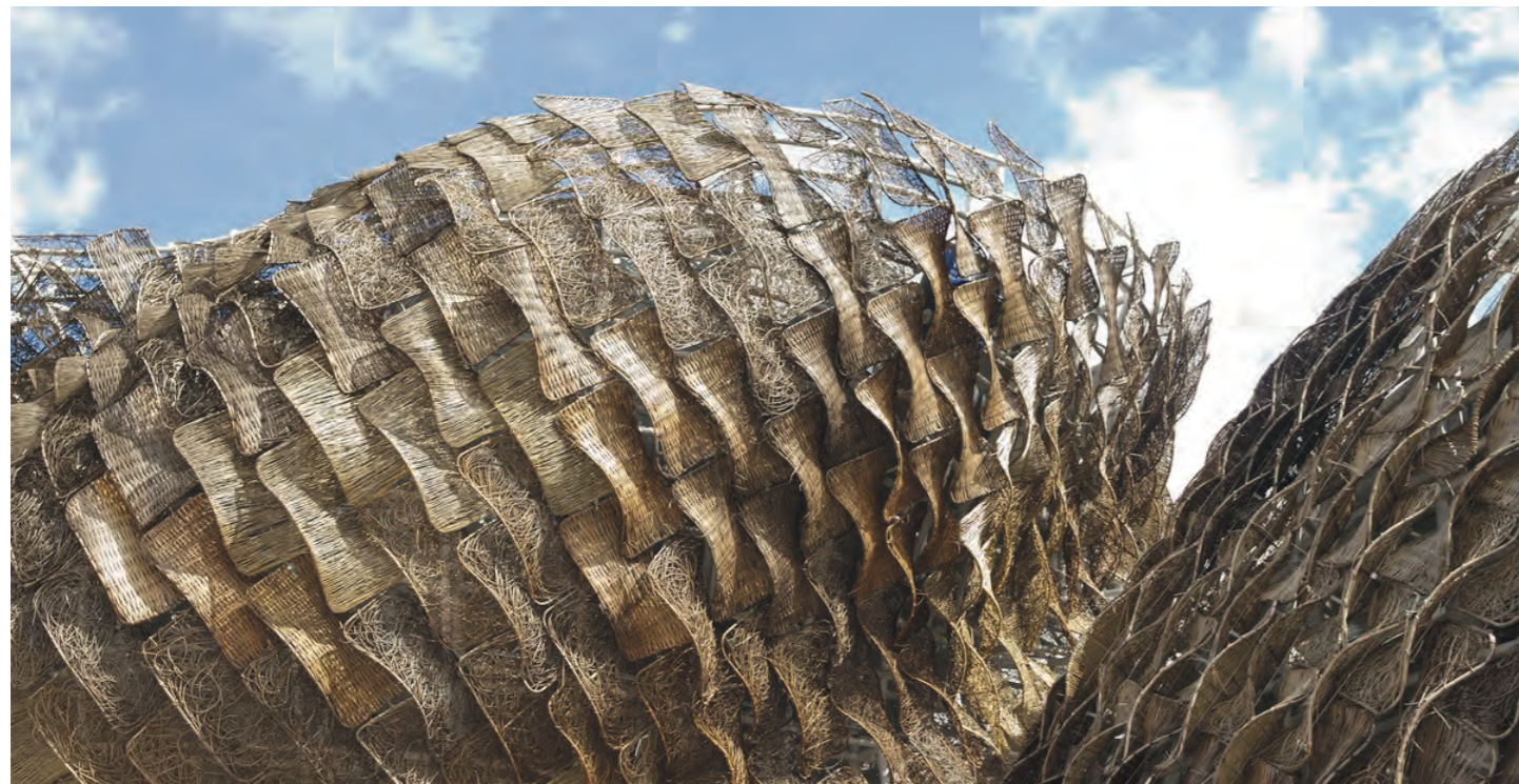
Las curvaturas y ondulaciones controladas mediante sistemas informáticos, contrastan con la materialidad artesanal a base de juncos y mimbres que compon las escamas de la fachada, siguiendo el ejemplo de la cestería tradicional china y española.
