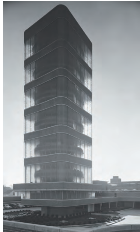
La fotografía tomada por Julius Schulman con la torre a contraluz revela la sección del edificio, en la que se alternan plantas y entre plantas dentro de la fachada de tubos de vidrio.
