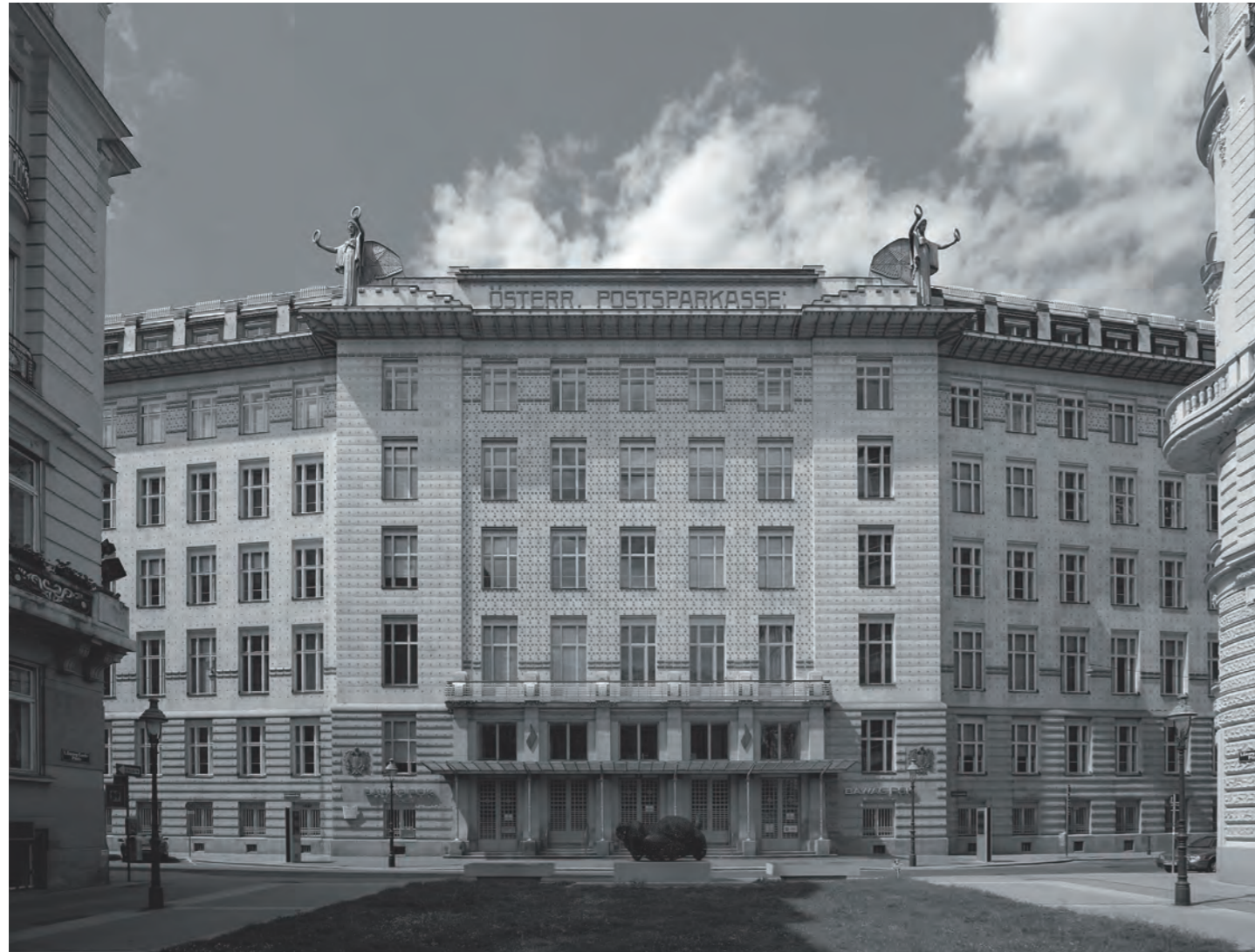
Fachada principal de la Caja Postal de Ahorros, Viena, Austria, 1903, Otto Wagner.
