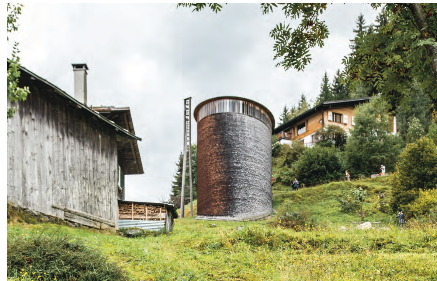
La fachada del valle muestra gracias a su curvatura como las tejas de la fachada han ido adquiriendo la pátina de los años gracias a su exposición al sol, al viento y la lluvia.
