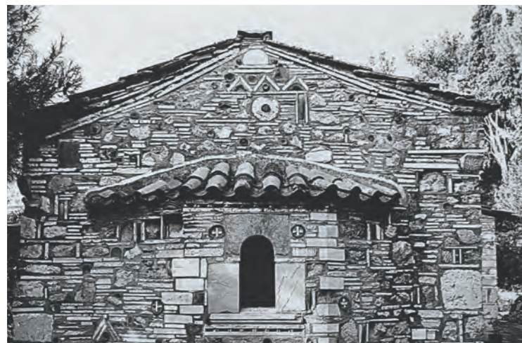
Fachada del ábside de San Dimitris Lombardiaris donde se puede observar la acumulación de diferentes restos componiendo un collage que construye la fábrica de los muros de la pequeña capilla.
