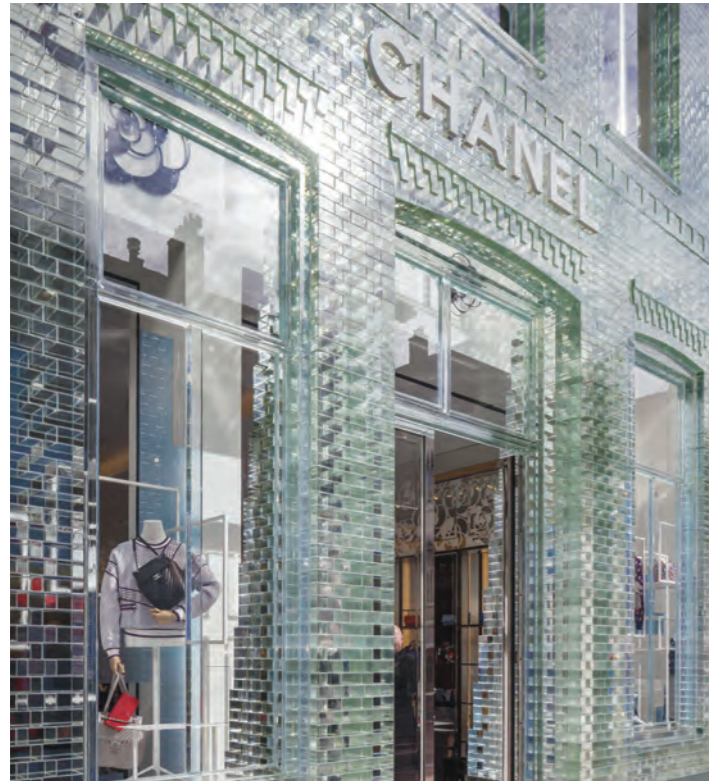
Los bloques de vidrio construyen una réplica exacta de la antigua fachada de arcilla cocida, manteniendo las molduras, dinteles, alféizares y ornamentos del aparejo tradicional de ladrillo.
