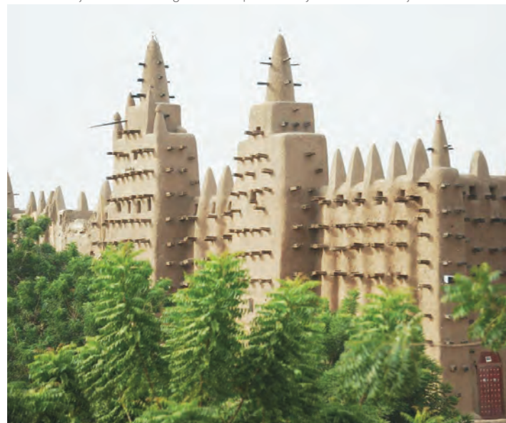
Todo el paisaje urbano está dominado por el color terroso de la arcilla, único material disponible en la región. La gran mezquita destaca por su dimensión sobre la trama irregular de la ciudad de Djenné en Mali. La estructura interna de madera presente en los muros, puntea la fachada dibujando una trama geométrica que ordena y da unidad al conjunto.
