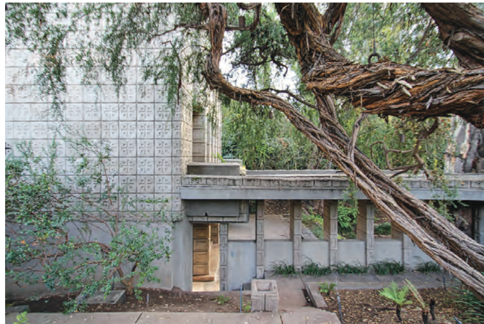
La fachada de la Miniatura queda ordenada por el empleo de las piezas de hormigón prefabricado que se transforman en un elemento de encajado de los muros estructurales, en celosía y al mismo tiempo en elemento ornamental.
