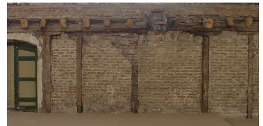
Estructura de entramado del Palacio de Ustariz
