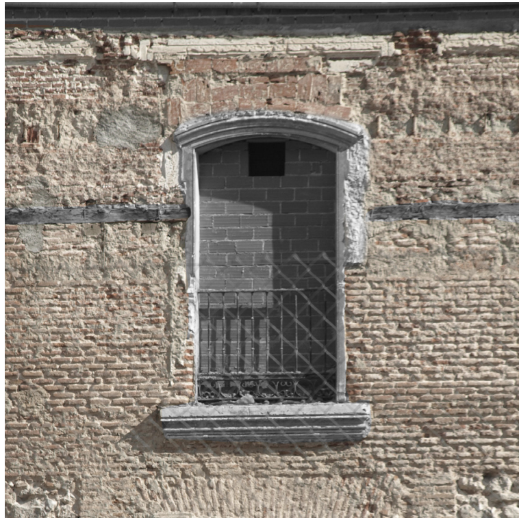
El cerramiento original de fábrica de ladrillo.
