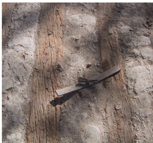
Entramado horizontal de viguetería de madera y relleno.
