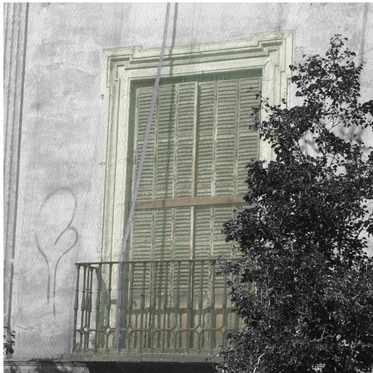
El mantenimiento de los huecos y carpinterías originales
