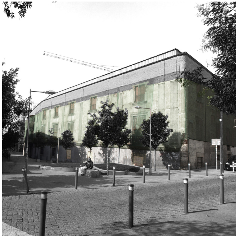
La conservación de la fachada neoclásica
