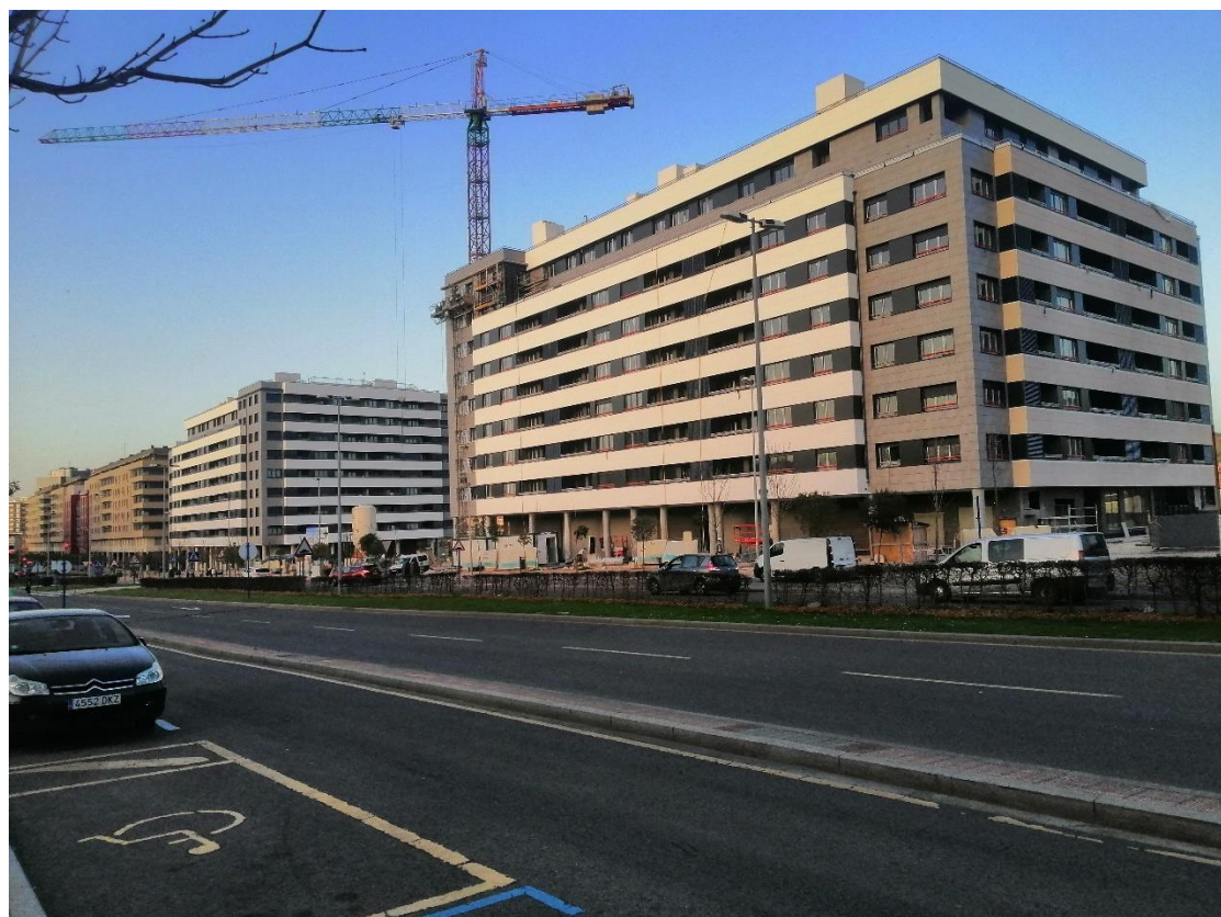
Fotografía 8. Obras colindantes. Fase II Ibaibarria (enero 2020). Fuente: autor
