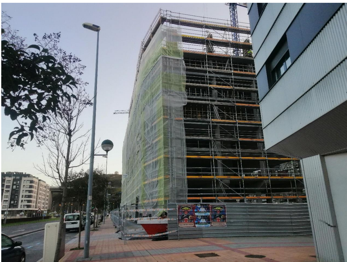
Fotografía 10. Obras colindantes (enero 2020). Fuente: autor
