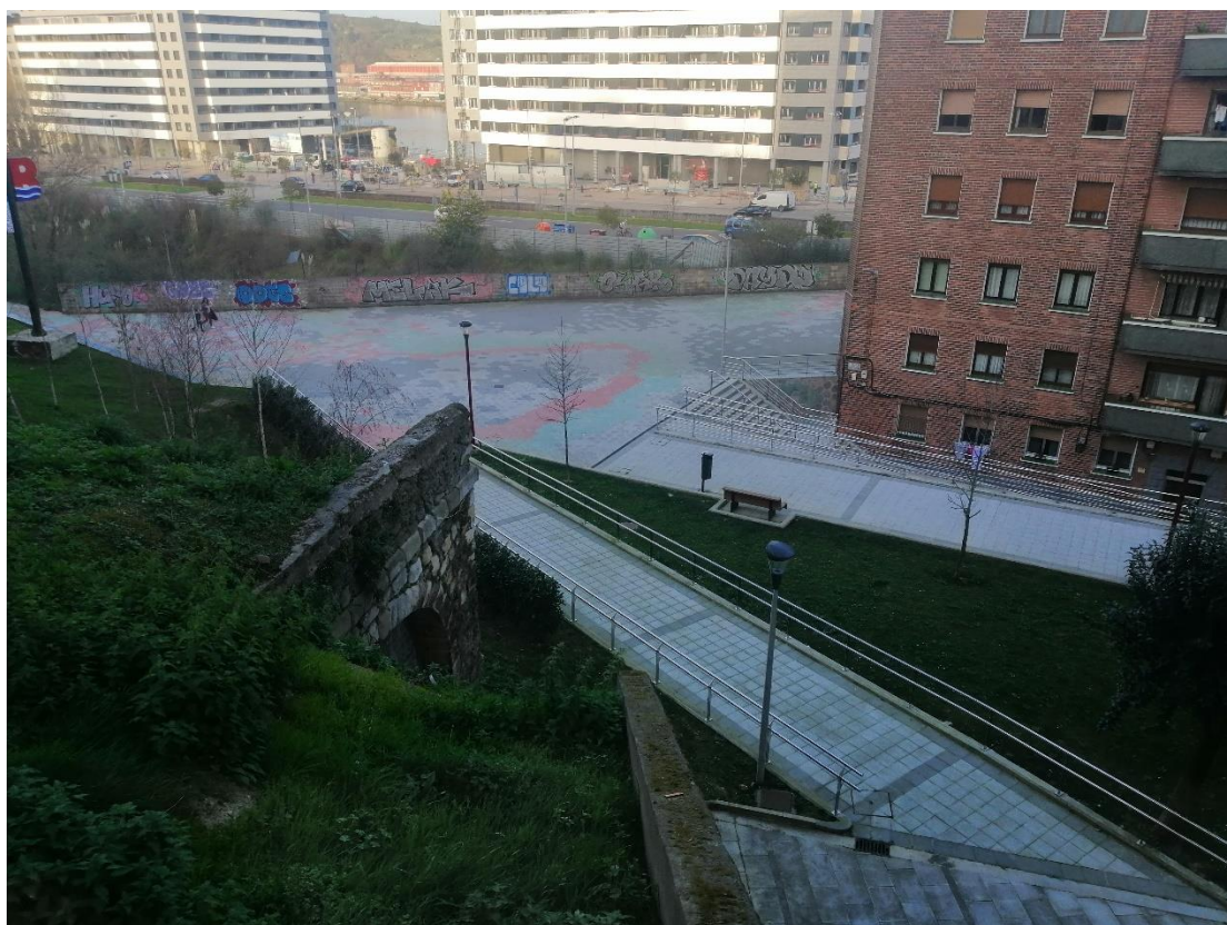
Fotografía 4. Vista del acceso inferior desde la parte superior (enero 2020). Fuente: autor
