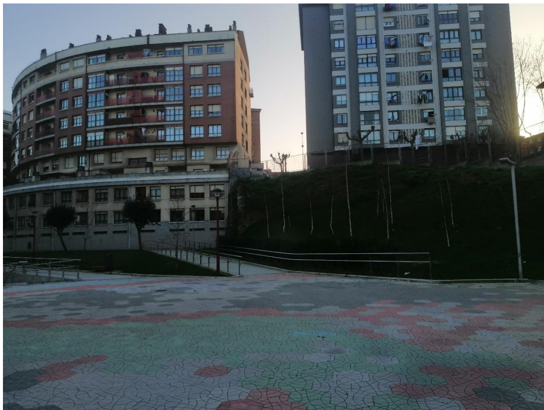
Fotografía 3. Vista frontal del acceso inferior (enero 2020). Fuente: autor
