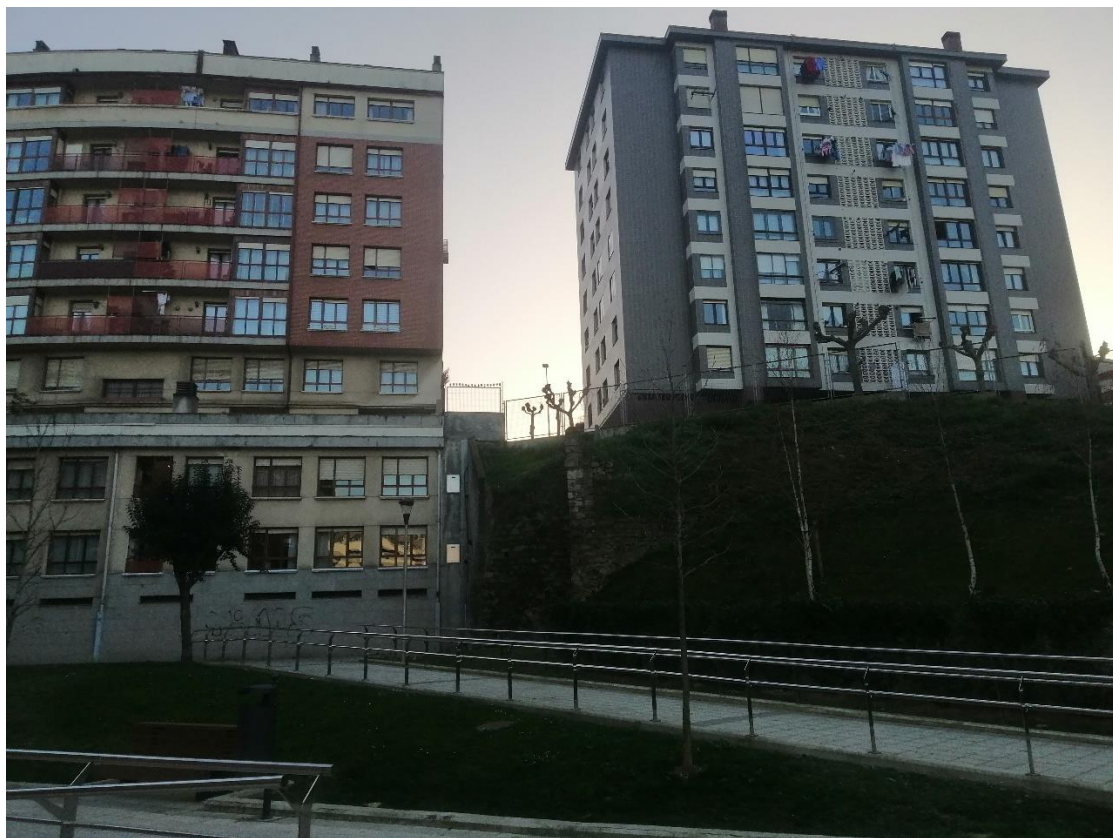
Fotografía 2. Vista frontal del acceso inferior (enero 2020). Fuente: autor
