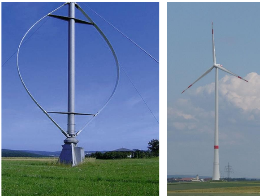
Figura 5. Aerogenerador VAWT (izquierda) y aerogenerador HAWT (derecha)
