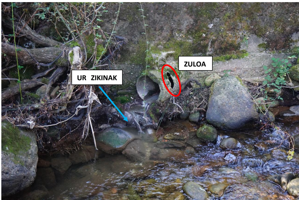
9. Irudia: Hustubidearen isurpen puntua. Iturria: Proiektuaren egileak ateratako argazkia.
