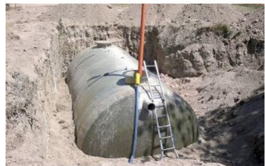
21. Irudia: Imhoff tankearen aurrefabrikatua.
