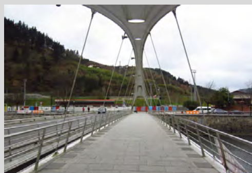
Detalle de la foto de la izquierda: puente peatonal adherido que da acceso a la zona deportiva.
