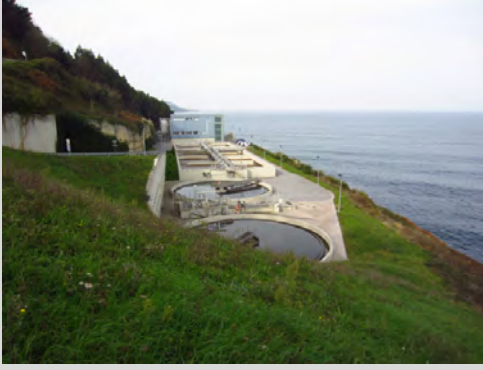
Depuradora de Ondarroa.
