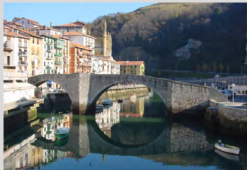
Puente "Zubi Zaharra" peatonal.
