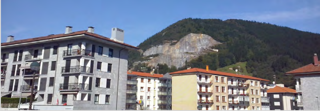
Revestimientos de fachadas en Markina-Xemein.
