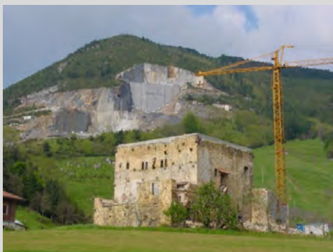
Casa torre de Ugarte en restauración (Markina-Xemein).
