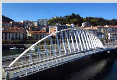
Puente "Itsasaurre" (Calatrava, 1995.)
