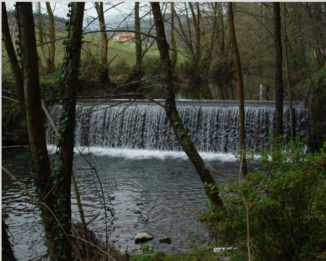
Presas en el río Urko (Etxebarria, entre Anzotegi y Markina-Xemein).
