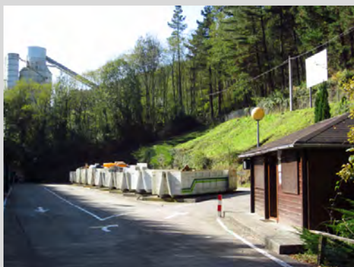
“Garbigune” de Markina-Xemein. Instalación para la recogida selectiva de residuos.
