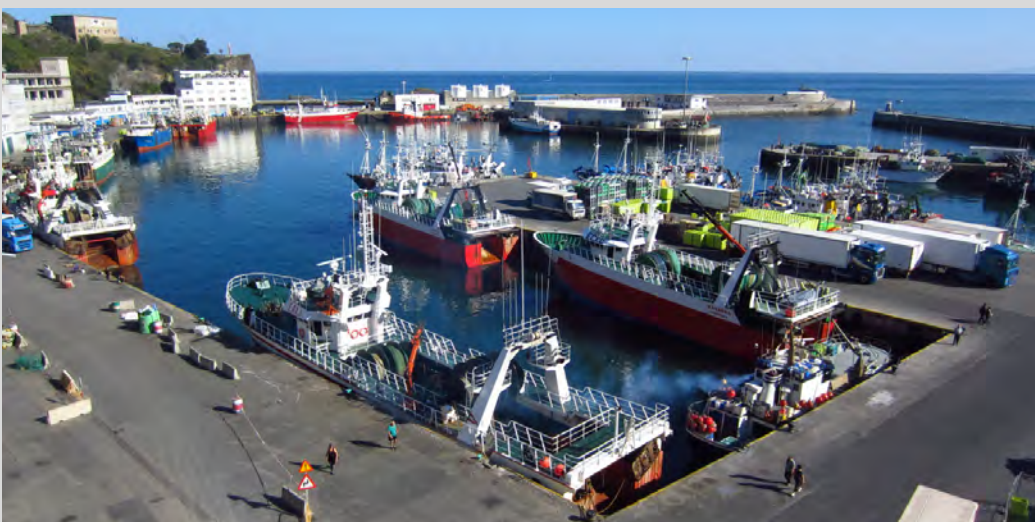
El puerto de Ondarroa es un puerto de pesca moderno, su configuración, las instalaciones y servicios que lo acompañan y el volumen de su actividad le confieren un carácter industrial.
