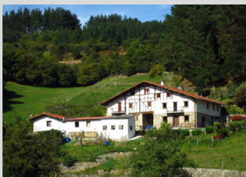
Ampliación aledaña para usos varios (Ziortza-Bolibar).
