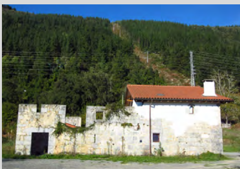
Caserío parcialmente rehabilitado para vivienda (Meabe)
