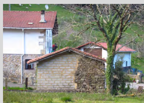
Una de tantas reparaciones realizadas con materiales modernos en Ziortza-Bolibar.
