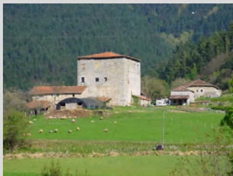
Casa torre de Barroeta, pendiente de restauración (Markina-Xemein).
