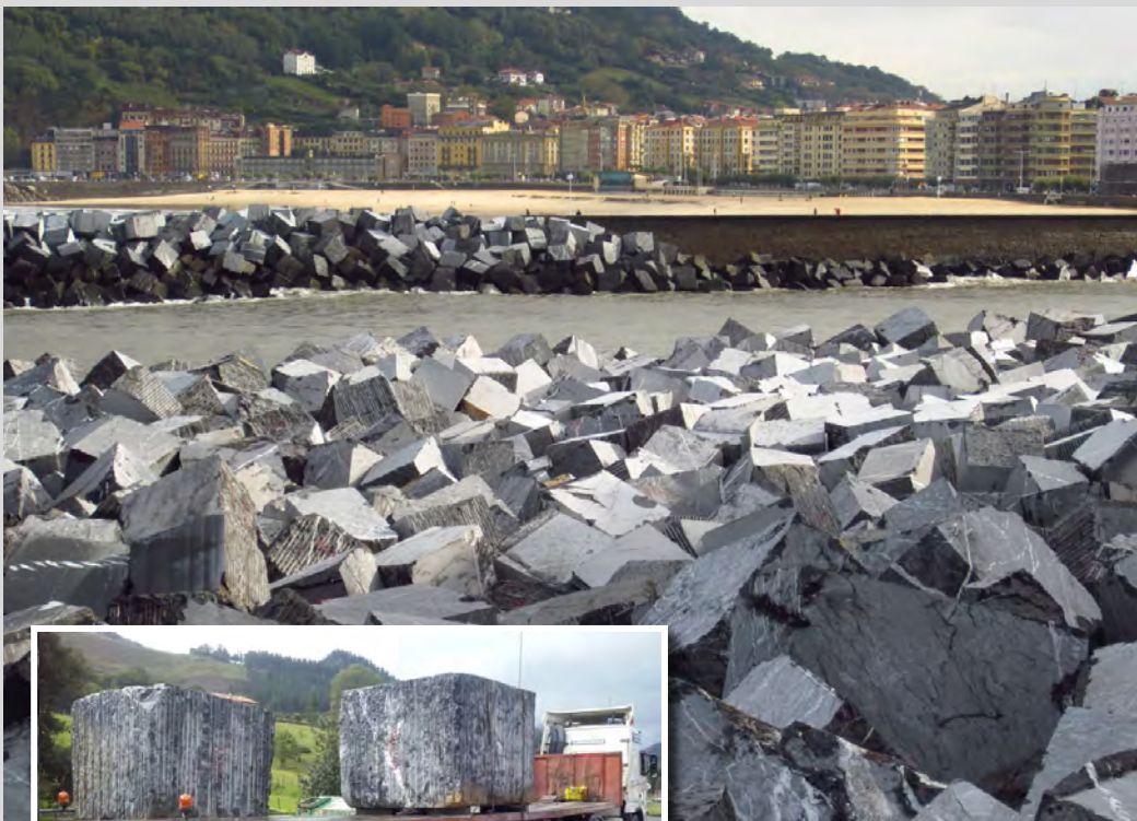
Protección frente al mar en la desembocadura del río Urumea en San Sebastián, obra de ampliación realizada en 2015 con bloques extraídos de las canteras de la comarca.
