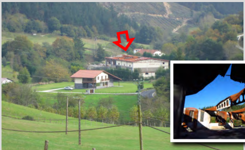
Señalado con la flecha un aserradero en el valle de Larruskain, que al poco de su construcción, sufrió un incendio y ha quedado abandonado (foto pequeña).
