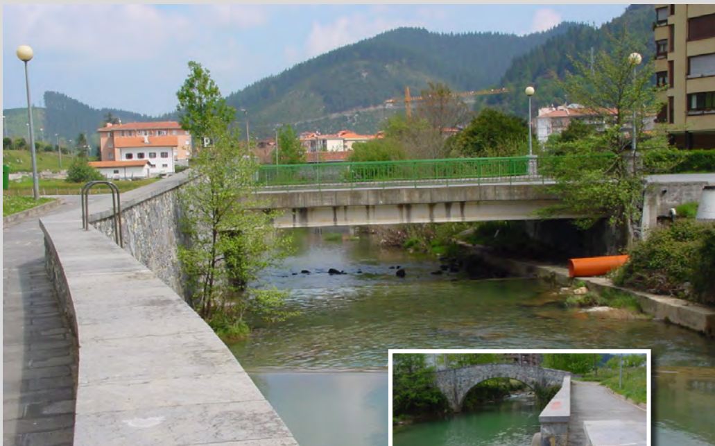
Puente nuevo de acceso al polideportivo de Markina-Xemein con prefabricados en disposición de dintel y, en la foto pequeña, puente de piedra peatonal restaurado. Ambos puentes están próximos y visualmente relacionados.
