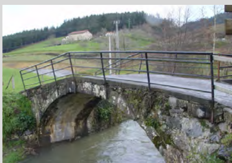
Soluciones urgentes de seguridad en Anzotegi (Etxebarria).
