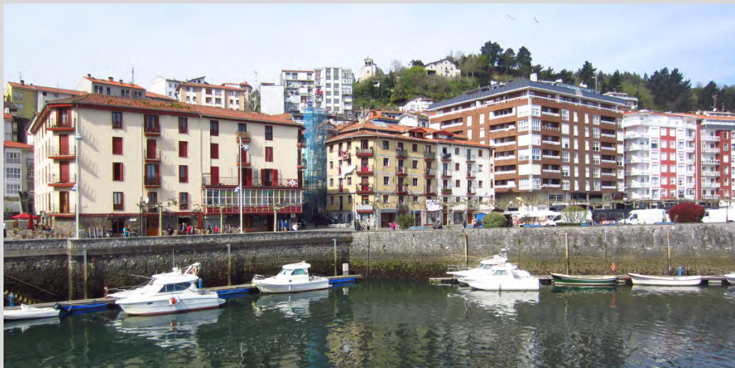
Fachadas exteriores, hacia la ría, de la zona de la Alameda.
