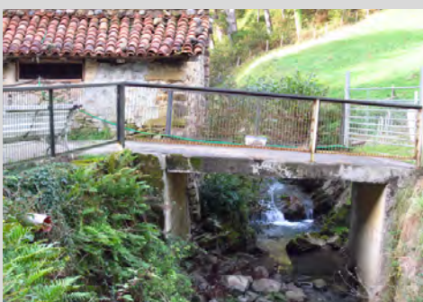
Contraste entre la singularidad del río Markola y la solución de paso, encofrado de cemento (Ziortza-Bolibar).
