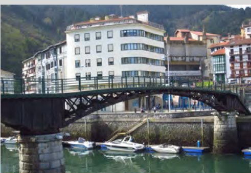
Puente de estructura de hierro, giratorio, que da acceso a la playa de Arrigorri.
