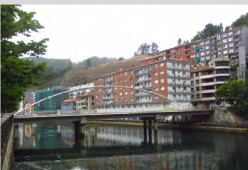
Puente con elementos prefabricados, adintelados, que da acceso a la zona deportiva.
