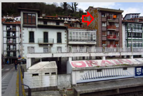
Vivienda de nueva construcción que trata de imitar a las de su entorno sobre la estructura de cemento del mercado.
