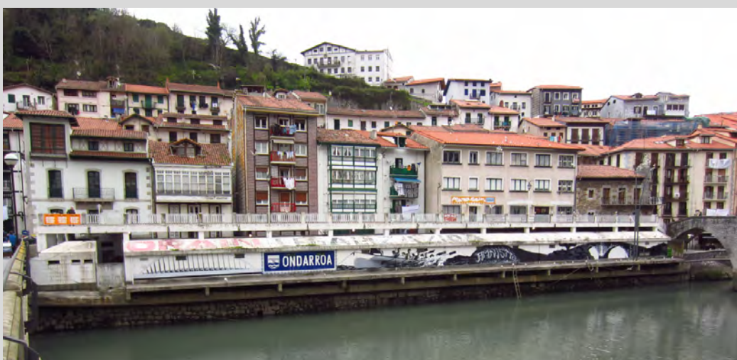
Secuencia de edificios enmarcados por el mercado, entre el puente nuevo y el puente "Zubi Zaharra".
