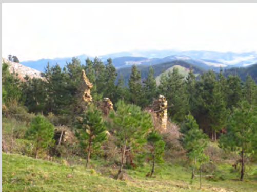
Caserío abandonado entre pinares en Longarte (Markina-Xemein).
