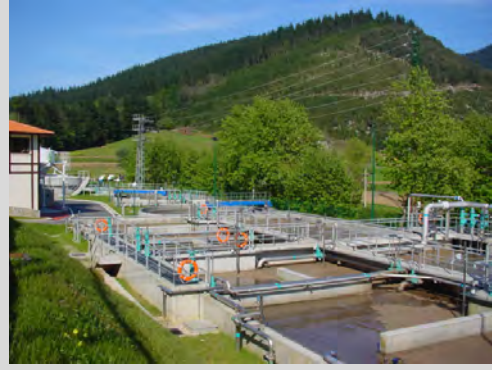
Depuradora de Markina-Xemein.
