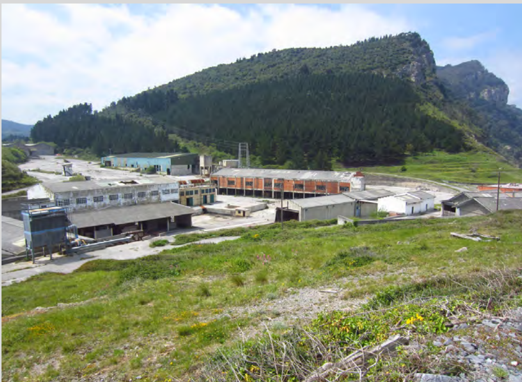
Instalaciones abandonadas de la empresa "Maderas de Lekeitio". Se trata de un entorno natural excepcional desde un punto de vista paisajístico y resultaría de interés recuperarlo. Al fondo a la derecha "La Atalaya" y detrás el monte Otoio.
