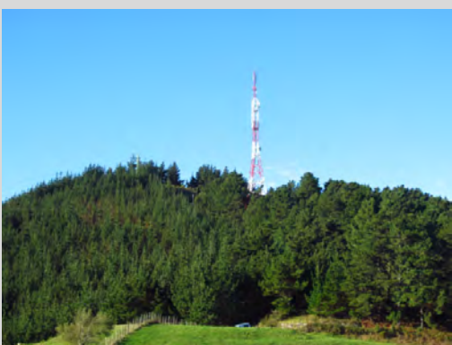
Antena de comunicación en el monte Santa Krutz (Ondarroa).
