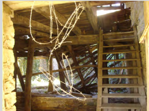
Estructura de madera de caserío abandonado (Ziortza).
