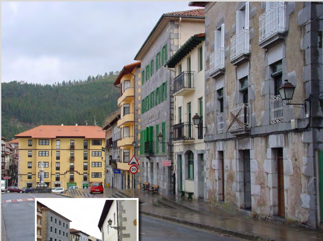
Fachadas restauradas de la calle del Carmen a principios de 2000 (Markina-Xemein). En la foto pequeña, la misma calle en dirección contraria.
