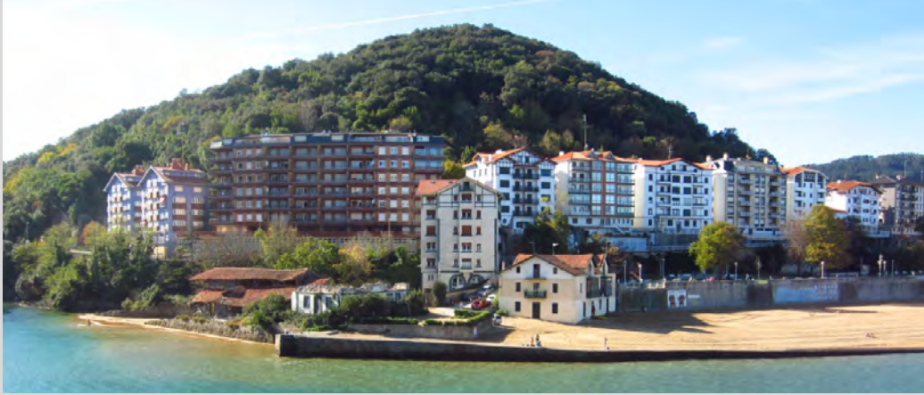
Bloques de viviendas en la ladera Norte del monte Lumentza
