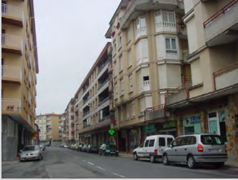
Bloques adosados con direcciones principales de fachadas contrastadas, calle Artibai.
