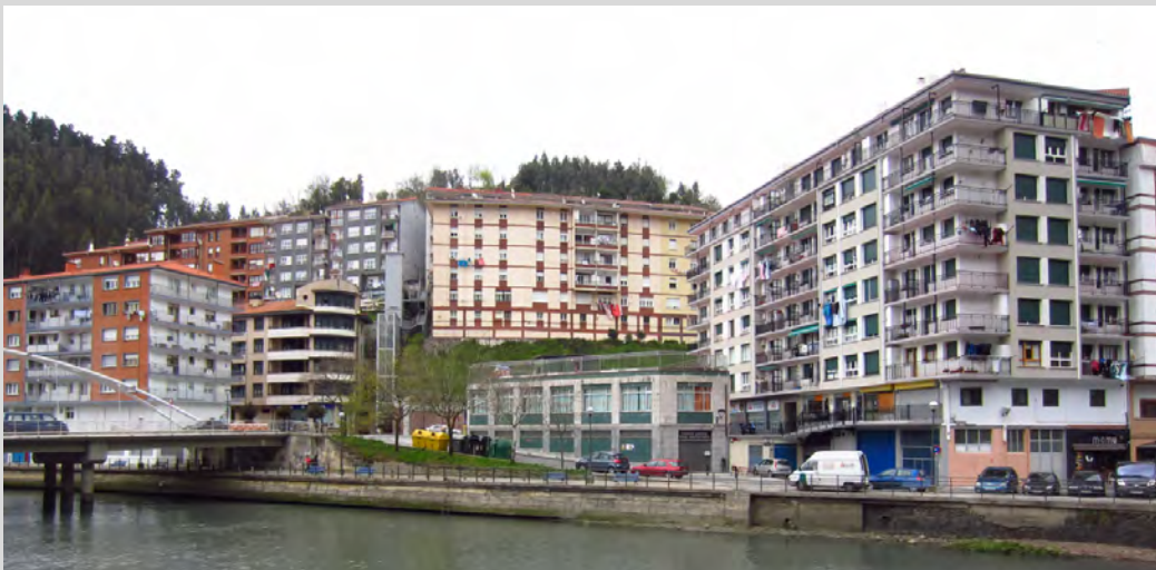
Exterior, hacia la ría, de la zona media de la calle San Ignacio.
