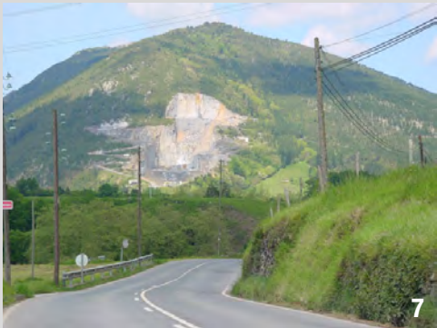
Carretera BI-2636 entre Etxebarria y Markina-Xemein.
