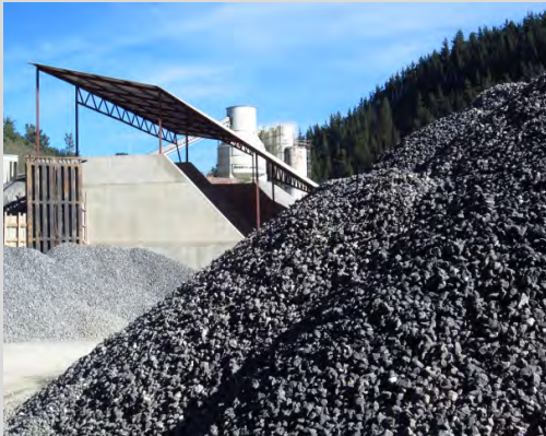
Instalaciones de la cantera.
