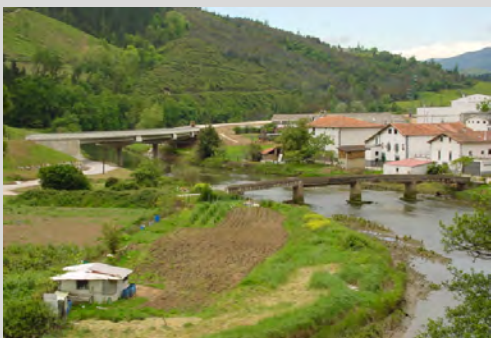
Puentes de Rentería, a la izquierda el puente nuevo de la variante de Ondarroa.
