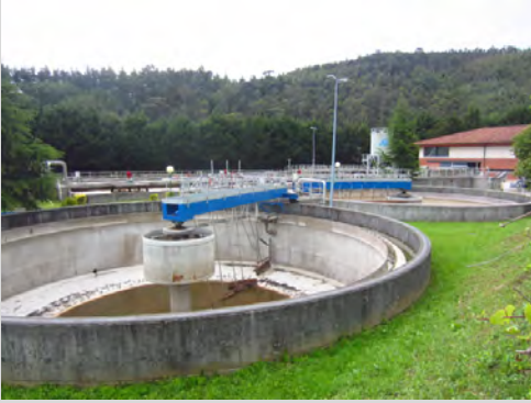
Depuradora de Lekeitio.
