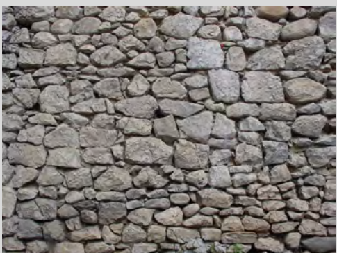
Muro de mampostería hecho con piedra caliza.
