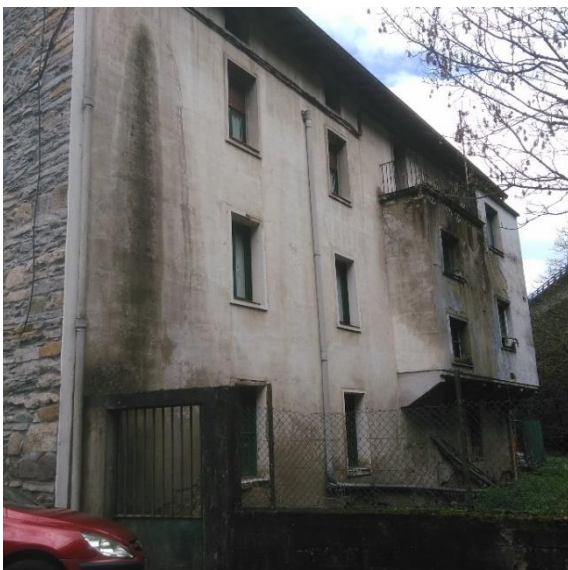
Fachada trasera (Sur)
