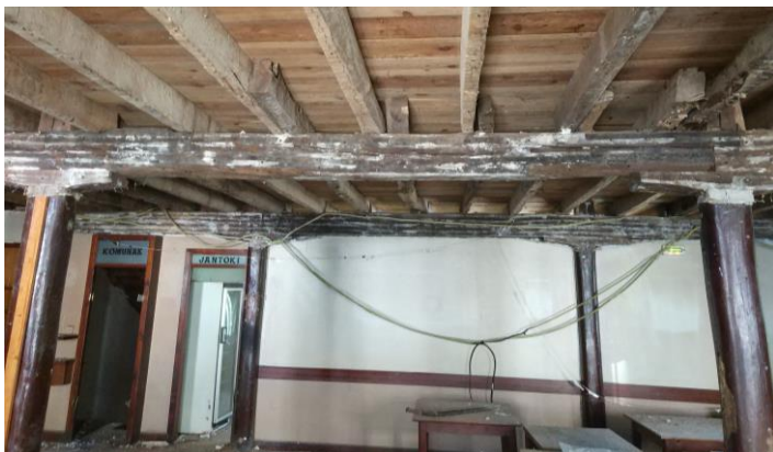
Viga V123 visto desde planta baja.
