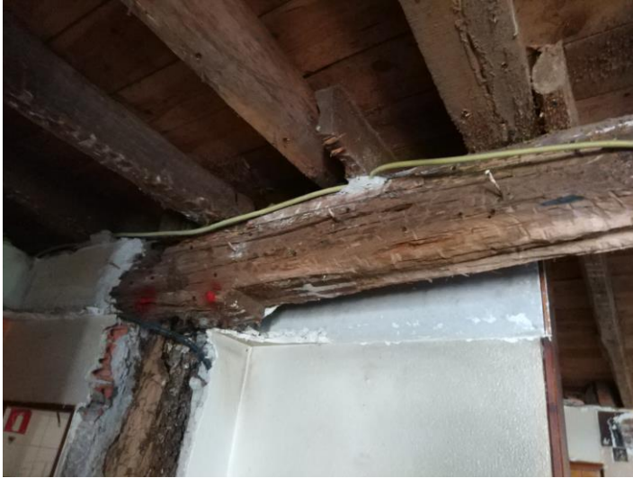
Encuentro entre pilar y viga sobre la barra del bar.
