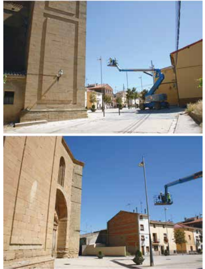
Figura 15.- Toma de los pares estereoscópicos de la fachada de la iglesia de Agoncillo con ayuda de una grúa autoportante.
