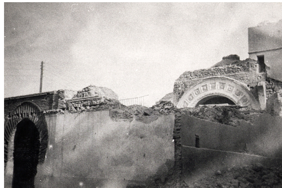
Fig. 6: Proceso de demolición de la iglesia de San Gil en Guadalajara. Foto Goñi. Ministerio de Cultura y Deporte. Archivo General de la Administración, fondo de Medios de Comunicación Social del Estado, IDD (03)084.000, caja F/00784, sobre 10
