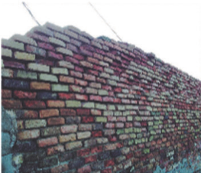
Fig. 5 Muro perimetral exterior del complejo.
