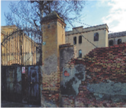
Fig. 5 Portón de acceso, fragmento fachada oeste.
