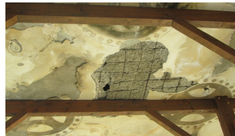
Ilustración 26: Imagen de la armadura del falso techo, imagen propia.
