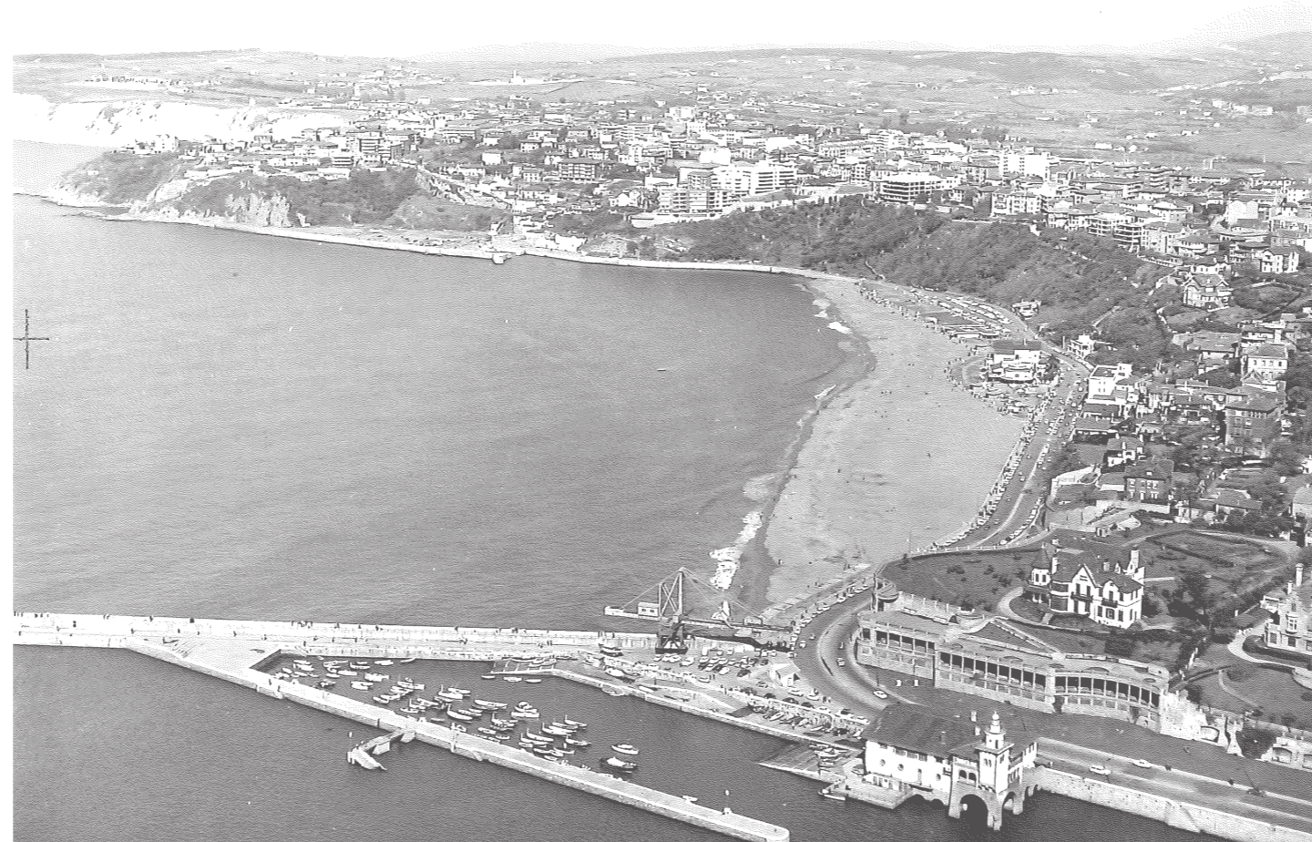
Ilustración 1: Vista aérea de las galerías con el Palacio Echevarrieta (imagen previa a la demolición de 1978), Ayuntamiento de Getxo.
