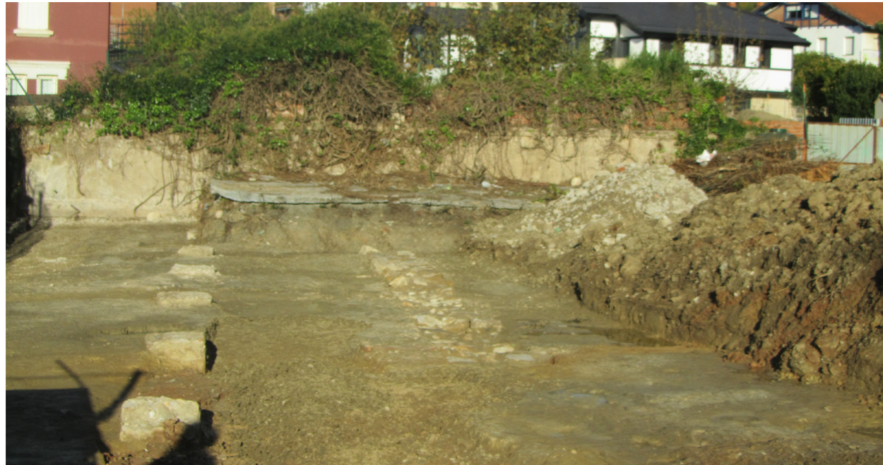
Ilustración 36: Imagen de la excavación en noviembre de 2018, imagen propia.
