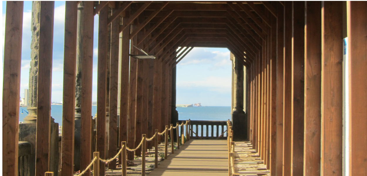
Ilustración 17: Imagen de la subestructura dispuesta para las visitas, fotografía propia.
