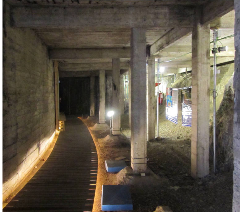
Ilustración 21: Imagen de cimentación del edificio tras la intervención, imagen propia.
