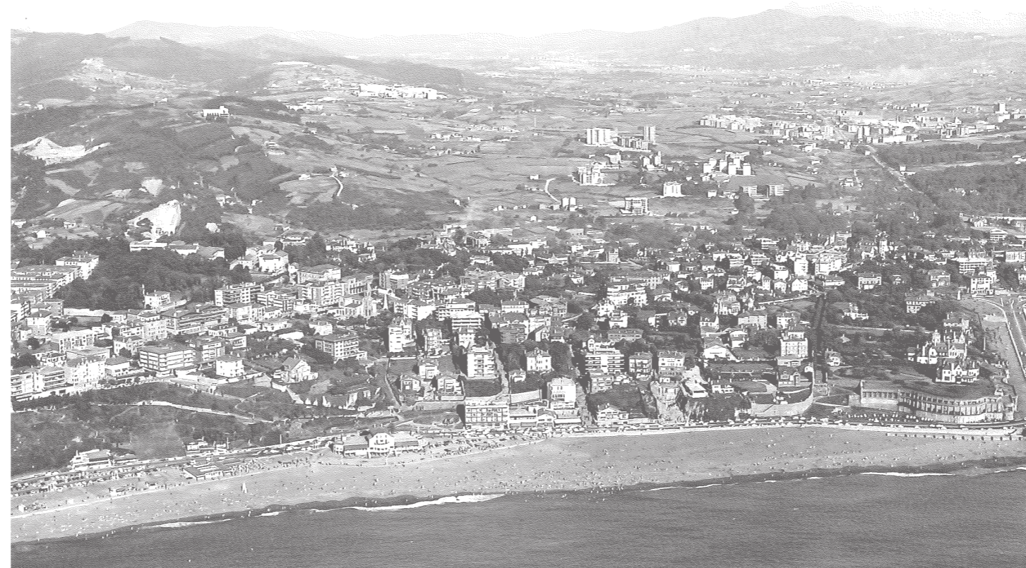
Ilustración 2: Frente de Ereaga desde el mar con el Palacio Echevarrieta (imagen previa a la demolición de 1978), Ayuntamiento de Getxo.
