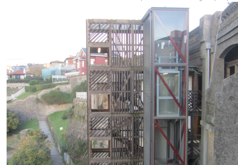
Ilustración 35: Imagen de una de las dos estructuras dispuestas para acceder a las galerías, imagen propia.
