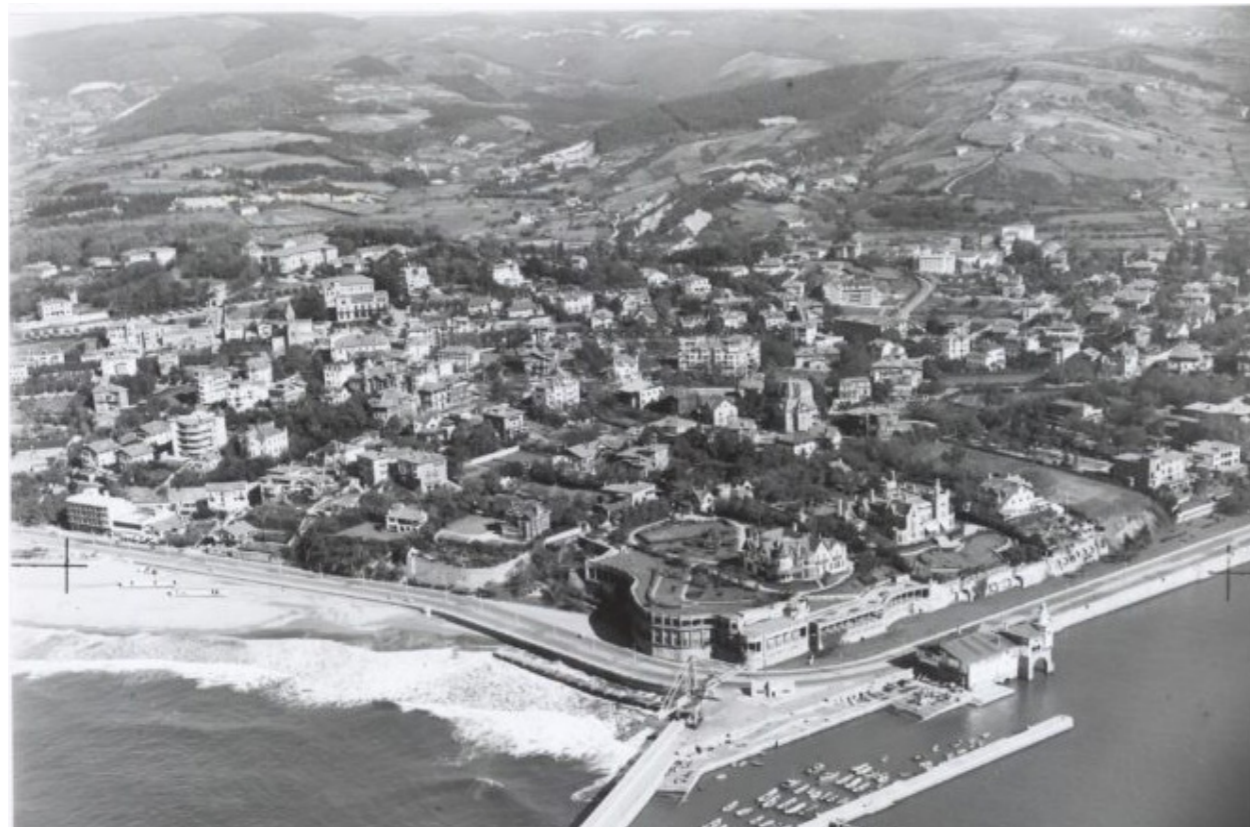
Ilustración 9: Imagen del área de Neguri con la galerías en cabeza y el Palacio Echevarrieta (imagen previa a la demolición 1978), Ayuntamiento de Getxo.
