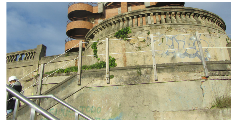
Ilustración 34: Imagen de la escalera de acceso a la terraza suroeste con una nueva balaustrada provisional, imagen propia.
