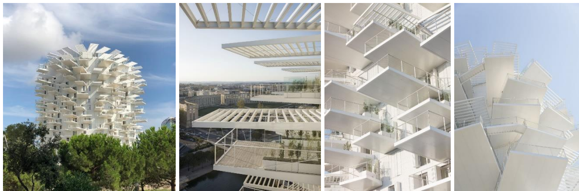
Imagen 15 Fotos de Torre De Viviendas
