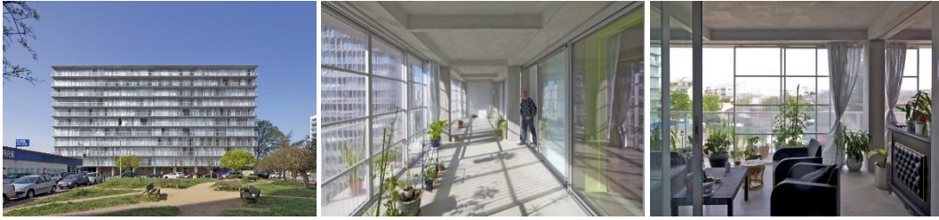
Imagen 7 Fotos de Transformación de 530 viviendas.
