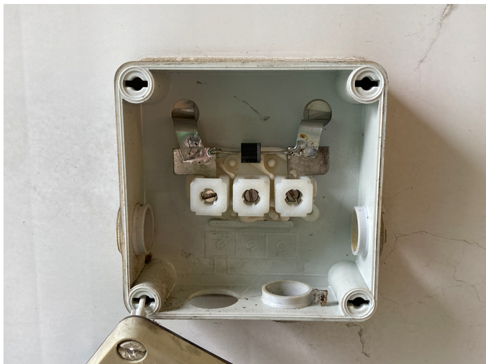
FIGURA 5.6. CONEXIONES DE LOS PANELES SOLARES.
