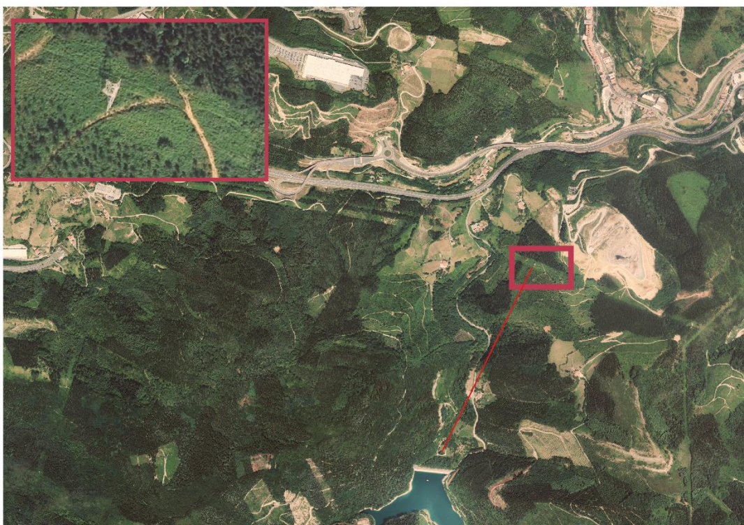
Irudia 28: Zentral hidroelektrikoan sortutako elektrizitatearen garraioa lurrazpiko tentsio altuko linea baten bitartez torre elektriko batera
