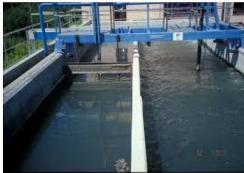
*Ilustración 6. Canal desarenador*
