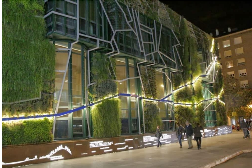
Figura 2.15. Fachada Vegetal del Palacio de Europa de Vitoria-Gasteiz.
