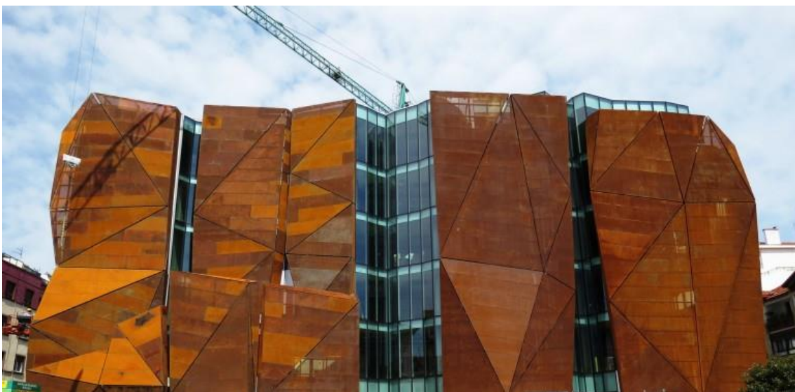
Figura 2.18. Fachada de doble piel resuelta en chapa perforada de la “Romo Kultur Etxea”.
