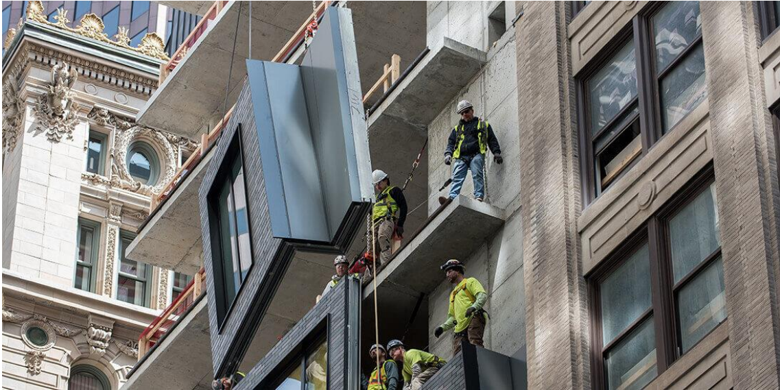
Figura 2.11. Envoltura industrializada, construcción edificio en EEUU.
