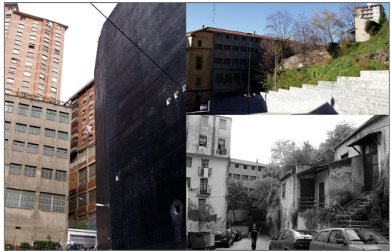
Fig. 8. Resquicios visiblemente deteriorados, de gran verticalidad, que se intercalan en cotas distintas.
