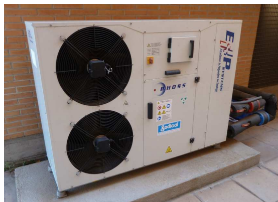
Fig. 6.4 Bomba de calor aire-agua
