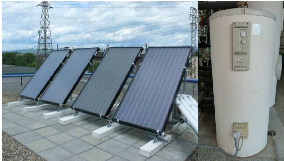
Fig. 6.8 Módulo de Energía Solar Térmica
