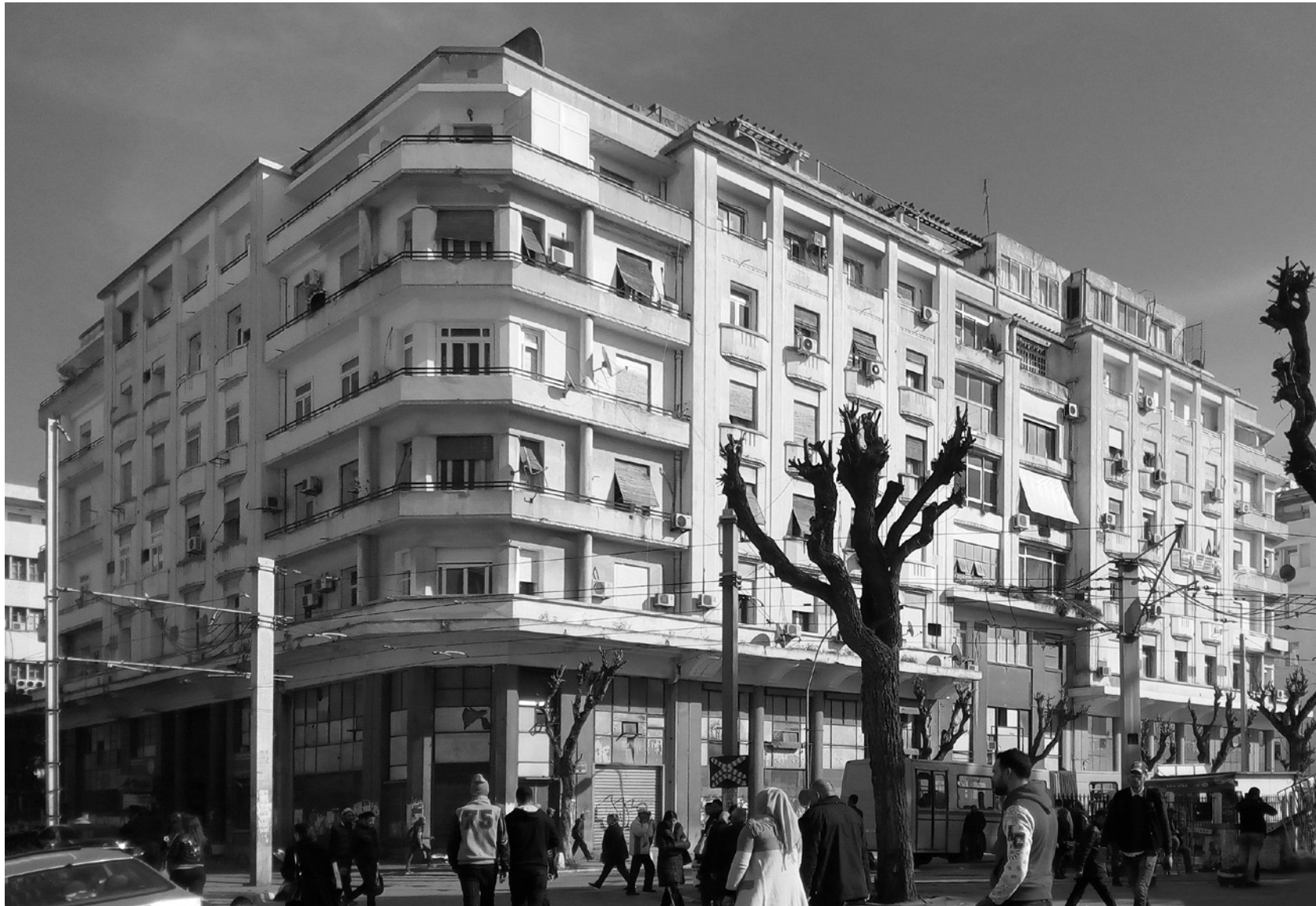
Fig. 9: Vista del bloque Schwich et Baizeau en la avenida Cartago. Hiriart y Seignouret, 1936
