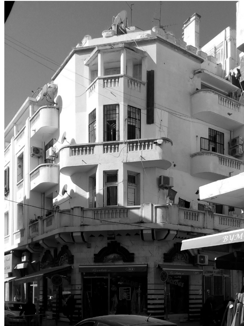
Fig. 7: Esquina del bloque de apartamentos de la Compagnie des Assurances générales . Hiriart y Seignouret, 1934
