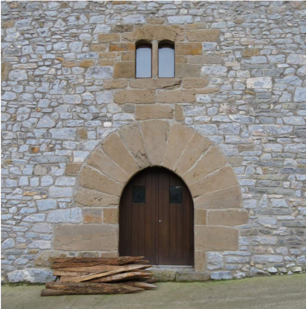
Fig. 20: Fachada de piedra del caserío Asuragoena después de la reforma
