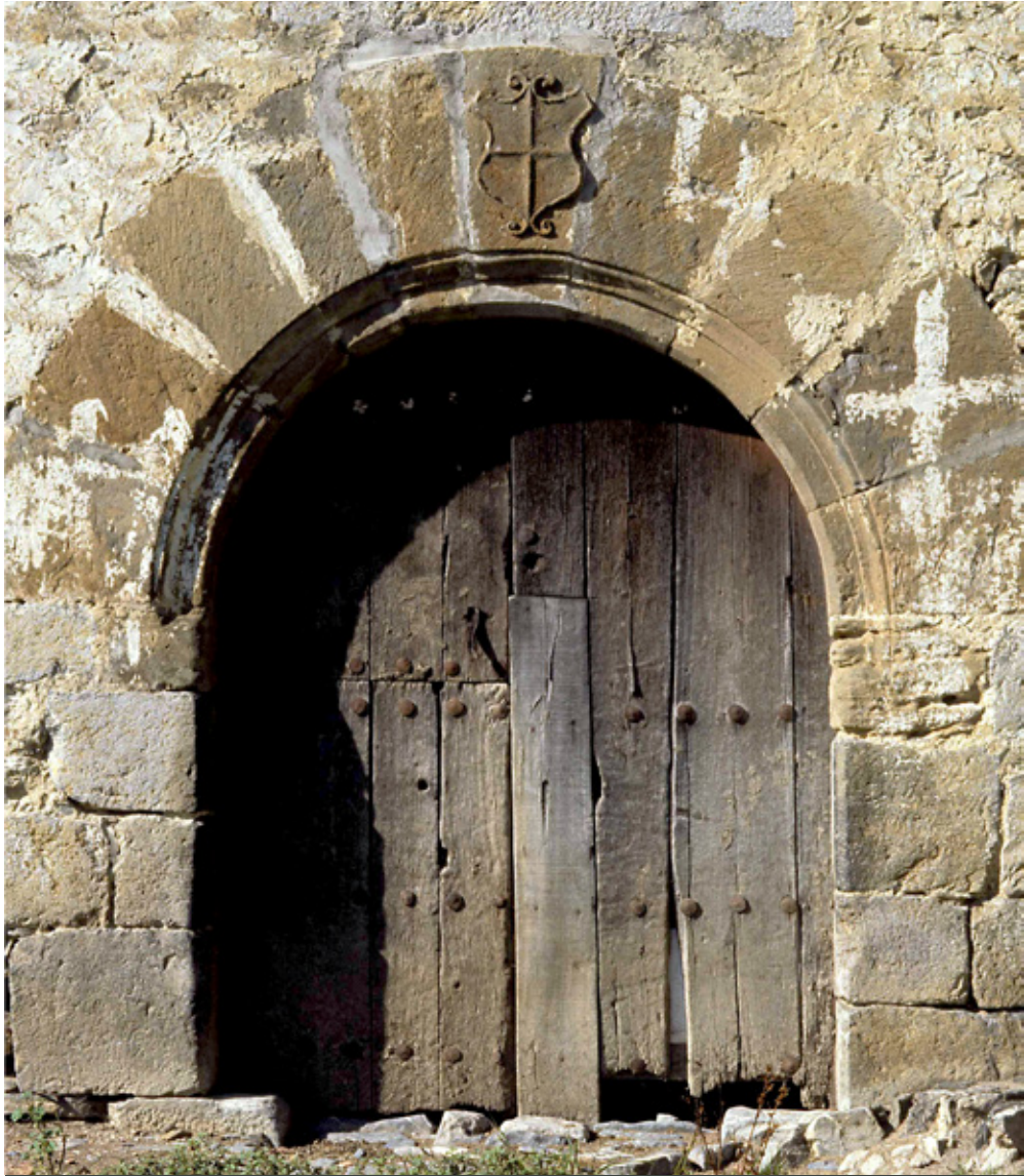
Fig. 24: Portada de acceso al caserío Iraola, antes de su restauración
