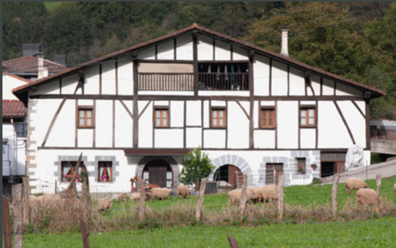
Fig. 33: Caserío Zula, dividido en dos, antes de ser reformado
