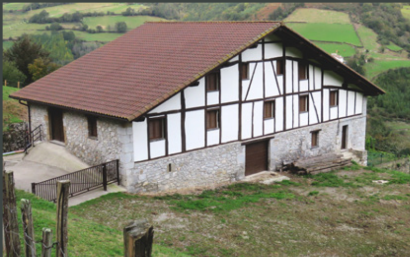
Fig. 18: Caserío Asuragoena, antes de la reforma
