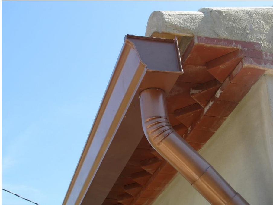
Figura 16. Canalón y bajante de vivienda unifamiliar. Fuente: canalonespozuelo.net (52)
