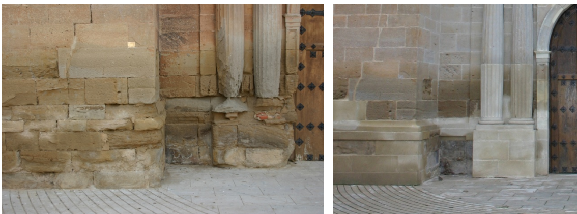
Figura 8. Dos vistas de detalle de los estados previo y posterior a la restauración de la fachada, correspondientes a 2007 (imagen izquierda) y 2014 (imagen derecha).
