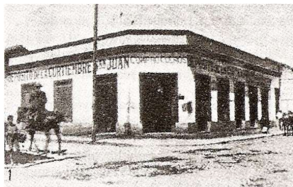
Photo 2. Tannerie San Juan de Curicó appartenant à Jean Etchegaray
