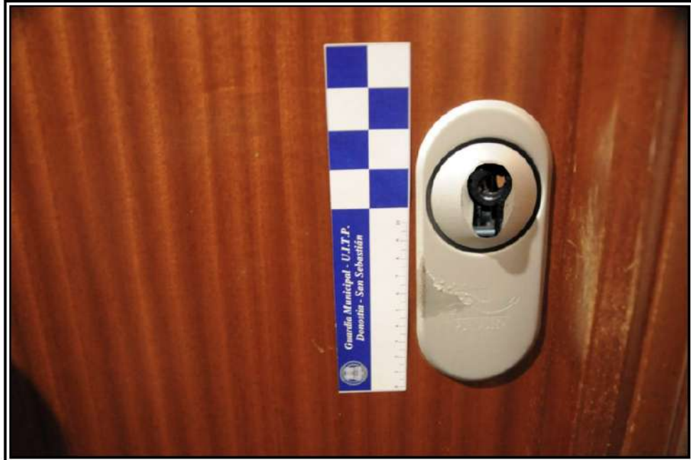
Fotografía nº 6: Mostrando vista de la cerradura forzada de la puerta principal de acceso al domicilio.
