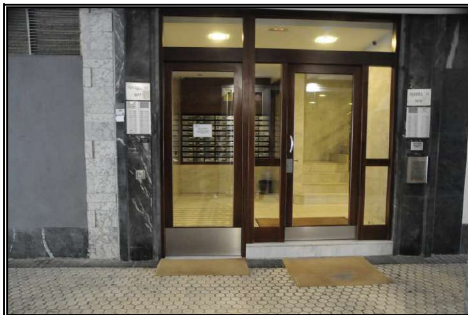
Fotografía nº 2: Mostrando puerta del portal número 7 de la avenida de Isabel II de esta ciudad. No presenta daño alguno.
