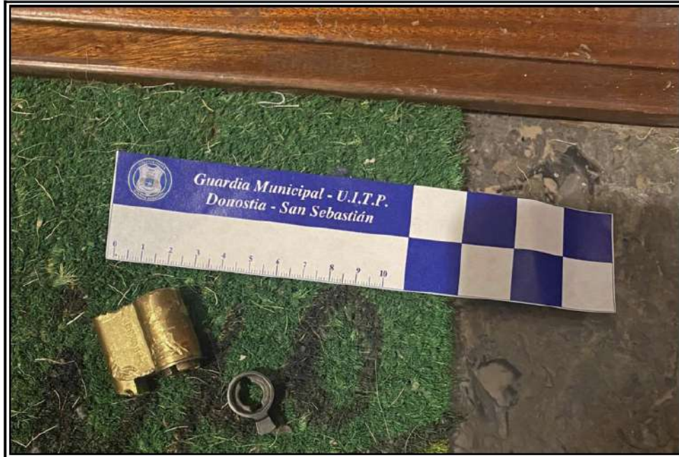
Fotografía nº 5: Mostrando vista de detalle del bombín exterior.
