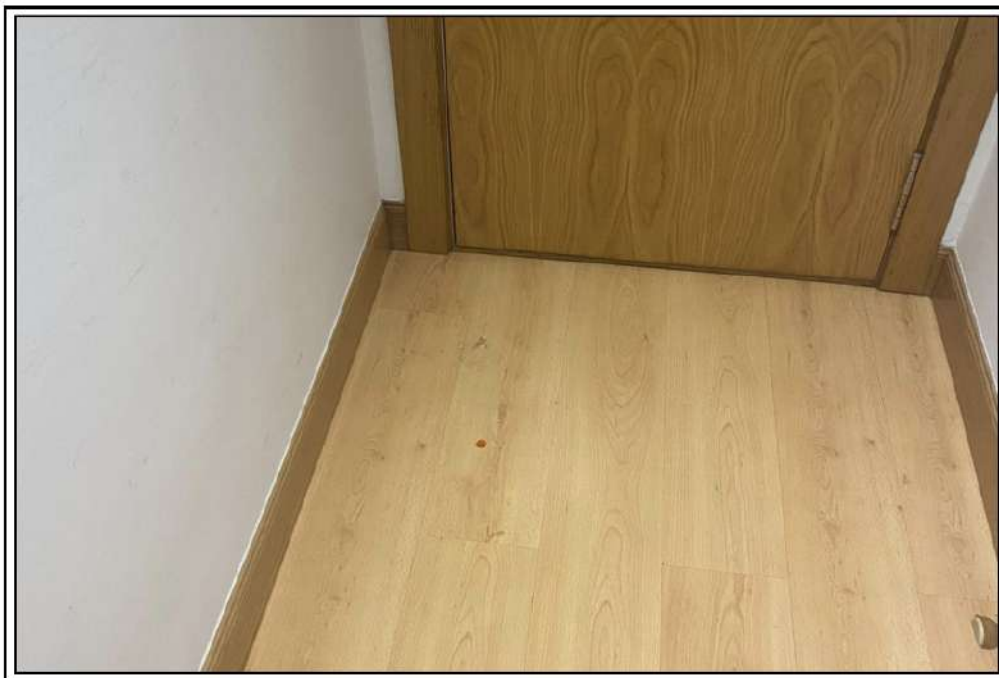
Fotografía nº 36: Vista general de la gota de sangre encontrada en el suelo junto a la puerta de acceso principal.
